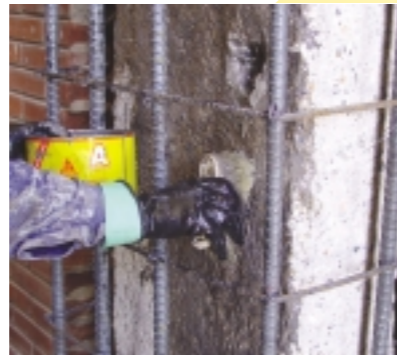
Recalce de columnas
