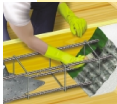
Adherencia de concreto fresco a endurecido.
