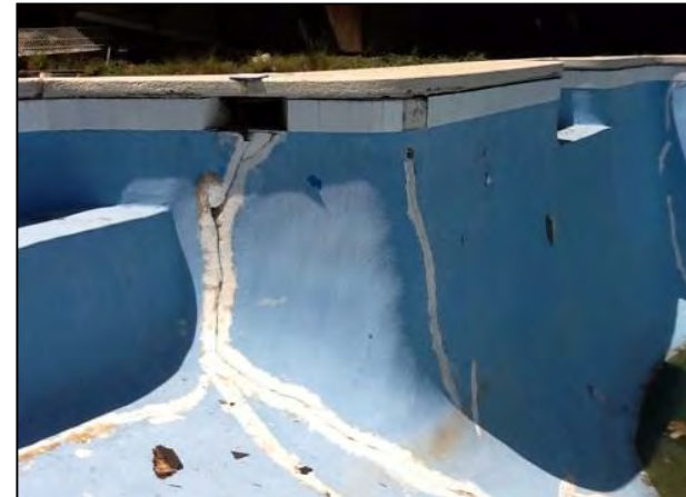
Asentamiento y fisuración
