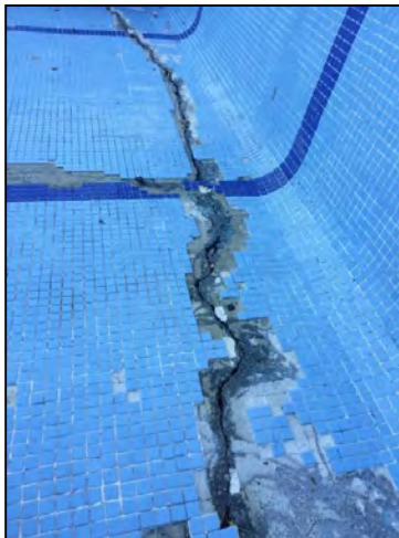
Fisuras en las losas y muros
