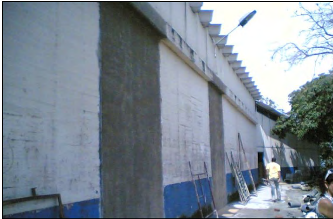
Tanque de agua potable Corbones – Armenia (2006)
