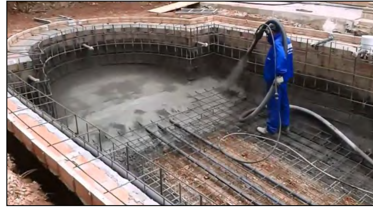
Secciones y acero insuficientes
