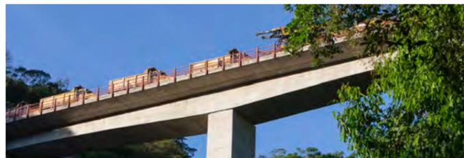
dratación del tipo SikaTard 935. Igualmente, para ciertas estructuras se especificaron concretos de altas resistencias tempranas a 17 horas de edad, las cuales solo se pudieron lograr mediante el uso de aditivos superplastificantes de última generación base policarboxilatos del tipo Sika Viscocrete 2100.
