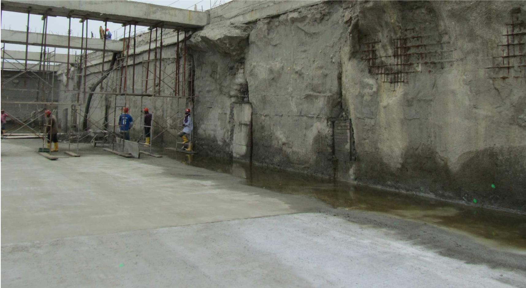
**Cimentación Pantalla pre-excavada** Filtraciones en juntas y hormigueros
