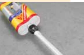
4. Coloque la boquilla de salida y mezclado del epóxico, asegure con la tuerca dispuesta para tal fin.
