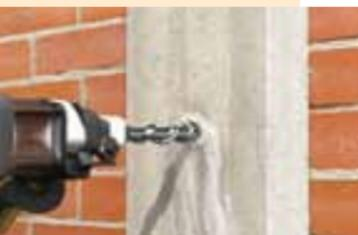
1. Taladre con una broca de diámetro entre 1/8 y 1/4 de pulgada mayor que el diámetro de la varilla o perno a anclar.
