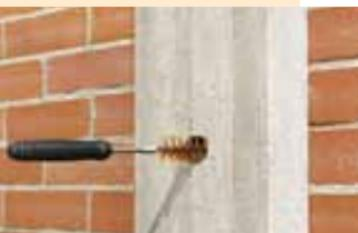
2. Limpie el hueco con un cepillo de cerda de alambre (churrusco) y use aire a presión para eliminar los residuos de la perforación. Evite el empozamiento de agua y la entrada de material contaminante.
