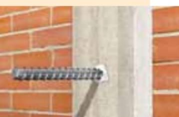
7. Introduzca la varilla o perno girándolos lentamente hasta que toquen el fondo de la perforación. Se debe garantizar el completo llenado de la perforación, evitando aire atrapado.
