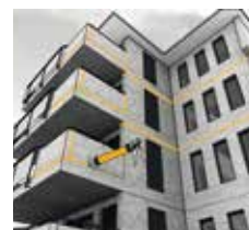
Juntas en concreto
