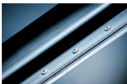
Unión atornillada o remachada: concentración de esfuerzos en las zonas donde se encuentran los remaches o tornillos.
