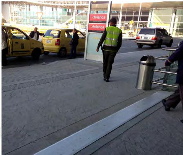
Es un sistema que consta de un híbrido de silicona y espuma precomprimida, instalado con un adhesivo epóxico en las caras de las juntas y con los fuelles de silicona sellados contra las caras de las juntas con un cordón de silicona adicional.
