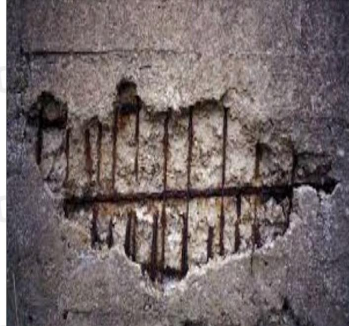
C.4 Durabilidad. En losas expuestas a condiciones severas (y en parqueaderos los gases de los vehículos atacan al concreto), el concreto debe tener una resistencia mínima de  $f'c=28\text{MPa}$ , según C.4.3 y C.7.7.6
