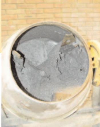
1. Añadir **Sikafluid®** a la mezcla de concreto con el agua de amasado de la mezcla.
