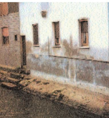
El mortero elaborado con arena, cemento y agua generalmente permite el paso de agua, la cual deteriora los acabados.
