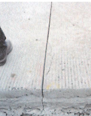
Todos hemos tenido la experiencia de una losa fisurada y después vemos como el agua pasa por las grietas generando un problema en la edificación.
