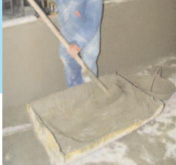
1. Colocar en la mezcladora el 80% del agua de amasado y la totalidad de la arena del diseño.
