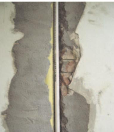
La aplicación de repellos sobre superficies donde la adherencia es complicada, nos causa muchas veces demoras y repeticiones del trabajo. El mortero suena “coco”, se fisura y se suelta.
