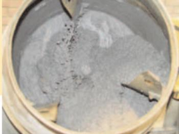
1. Viene listo para usar, agregándose el **Sikaset®L** al agua de amasado o directamente a la mezcla del concreto.
