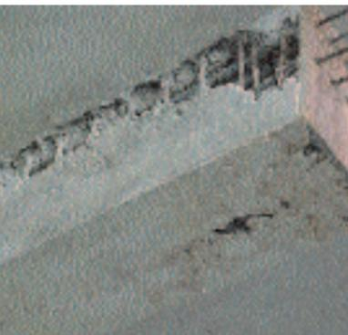
Deterioro del concreto en vigas y columnas por mala compactación (hormigueros)
