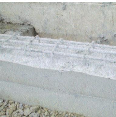
Los concretos recién colocados no adhieren adecuadamente a los concretos existentes o ya endurecidos.
