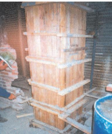
La formaleta es utilizada para moldear el concreto o como base para fundir placas aéreas. Para que no se pegue al concreto cuando éste endurece, se debe colocar un desformaletante que no engrase ni manche el concreto.
