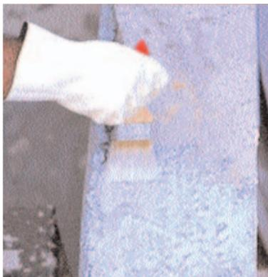
Aplicación del puente de adherencia para la pega del concreto fresco
