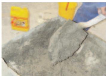
Se deben aplicar 3 capas de mortero impermeable en un espesor aproximadamente de 2.5 cm, teniendo en cuenta los siguientes pasos:
