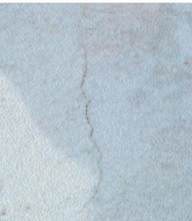
El viento y el sol resecan el concreto rápidamente, generando grietas y bajando la resistencia.
