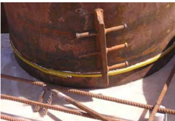
Transición Acero/ Concreto
