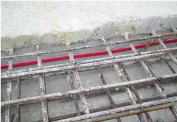
Juntas de Construcción
