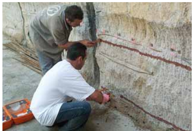
Junta entre muro pantalla y losa
