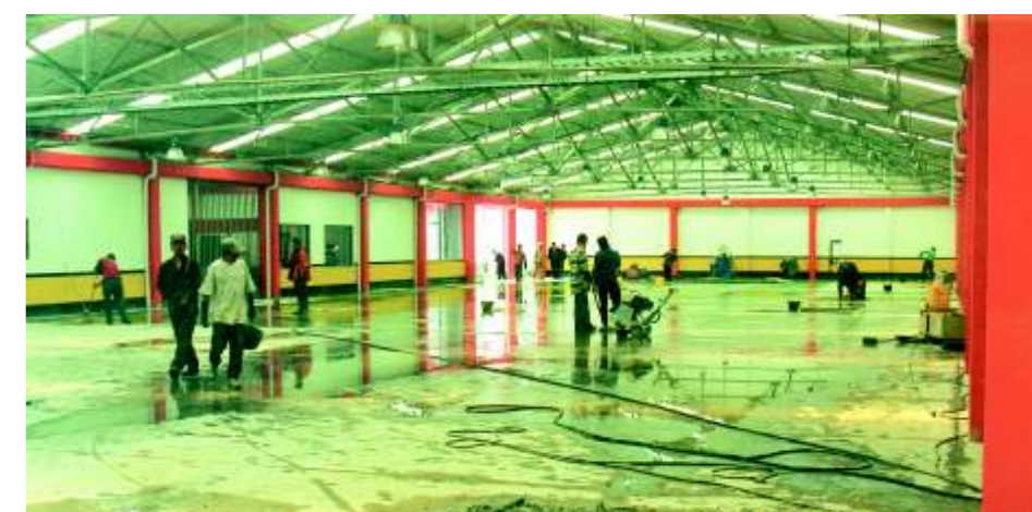
Proceso de fundido y terminado de los pisos de las bodegas
