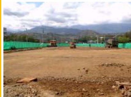
Proceso de compactación del terreno
