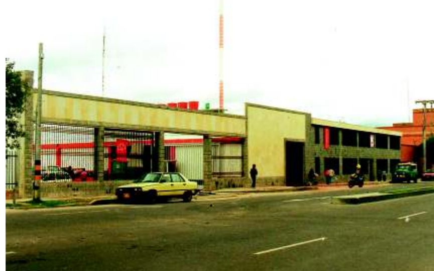
Fachada Centro Integral de Servicios Morato - Bogotá
