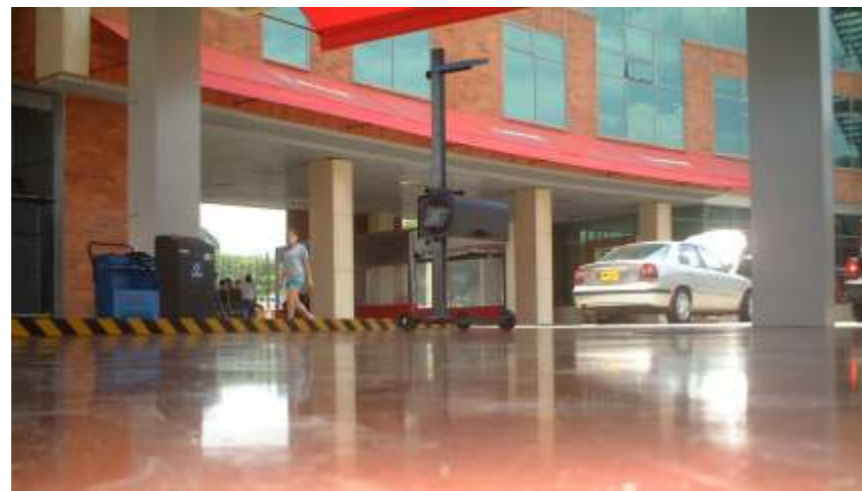
Pisos endurecidos en zonas de inspección
