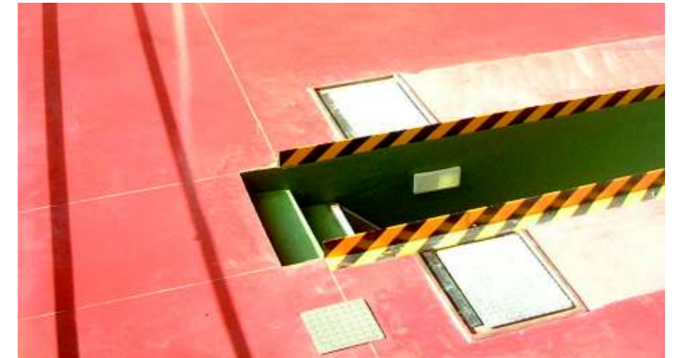
Detalle de los cárcamos
