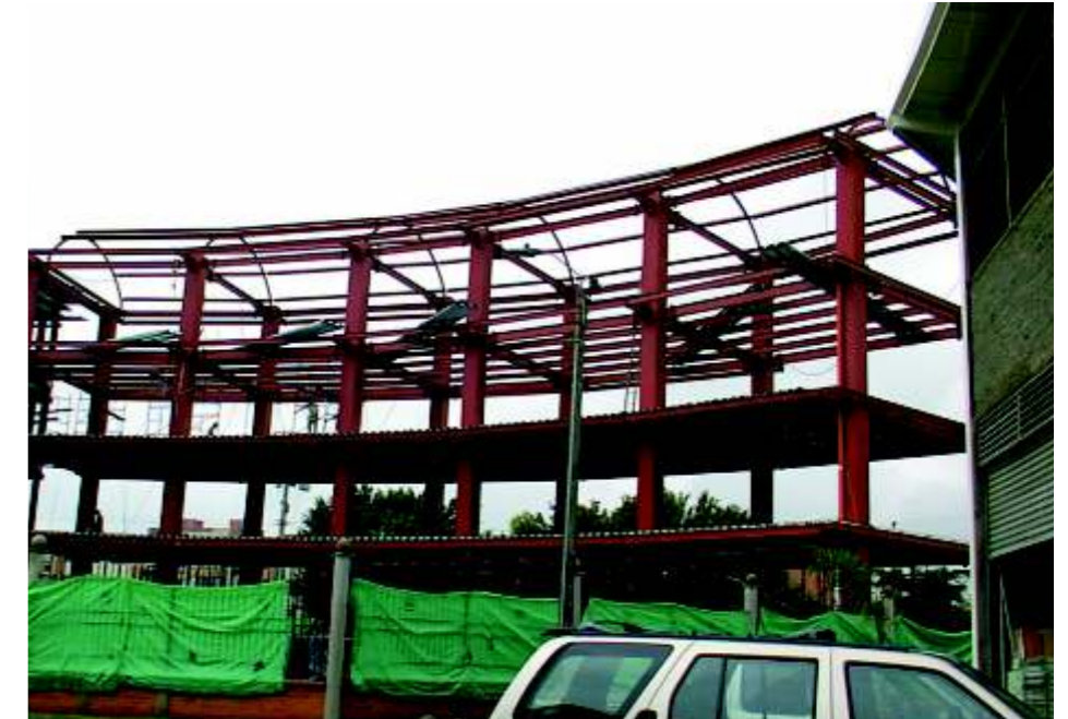
Estructura metálica protegida con Esmalte Epóxico Serie 33 e imprimada con el Imprimante Epóxico Rojo
