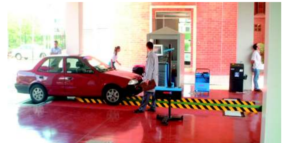
Cárcamos de inspección ya en servicio
