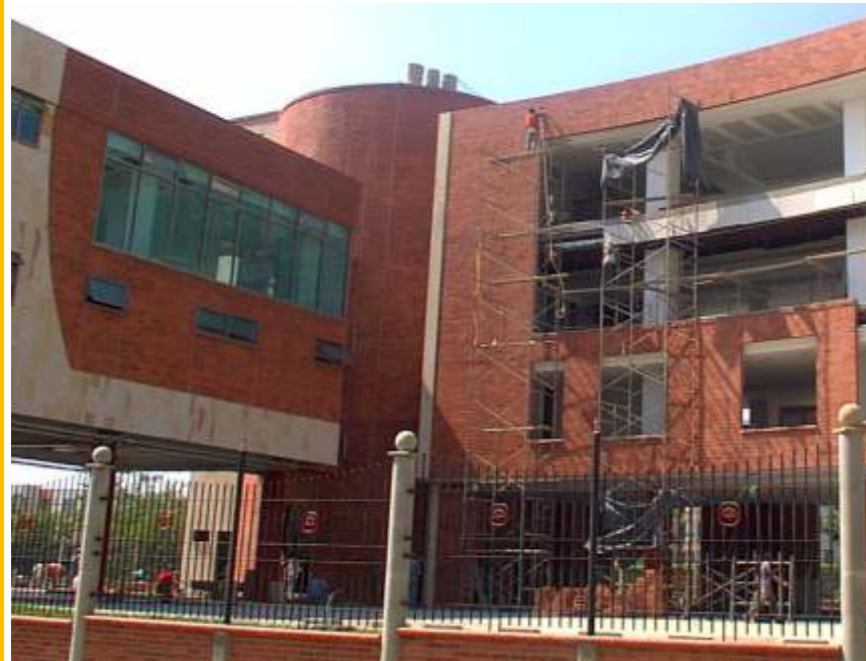
Limpeza y protección de la fachada (SikaLimpiador R - SikaTransparente)
