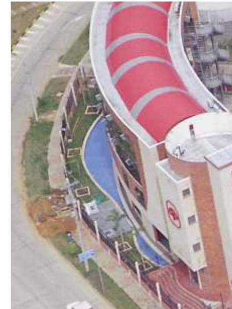
Espejos de agua construidos en concreto impermeable
