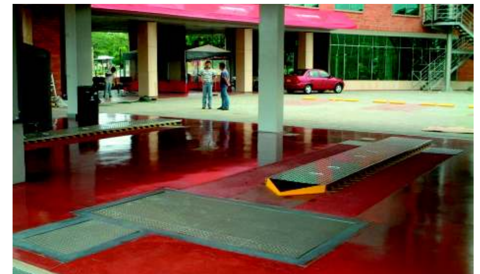
Vista general de cárcamos y fosos de inspección
