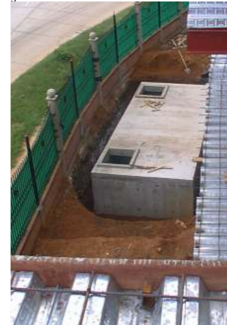
Tanque para depósito de agua
