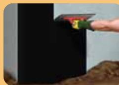
Aplique dos capas de **Igol®Cimentación** con llana metálica o con brocha.
