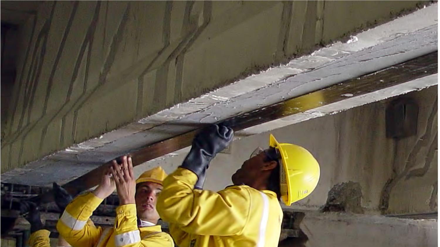
Los adhesivos rígidos se emplean cuando se requiere unir piezas (de materiales iguales o distintos) entre las cuales se necesita transferir cargas estáticas o dinámicas durante todo el ciclo de vida. En estos casos es necesario un sistema de pegado uniforme y consistente.
