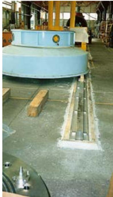
funcionamiento de los equipos, se debe utilizar **Sikadur®-42 Anclaje**, mortero epóxico fluido, de excelentes re-sistencias mecánicas, bajo módulo de elasticidad, que permite absorber estos esfuerzos mecánicos. No emplear **Sikadur®-42 Anclaje** cuando la temperatura de operación supere los 50 °C.
