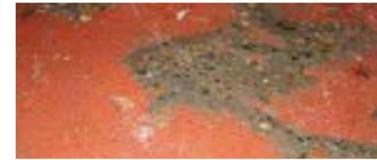
Los pisos en estas áreas con temperatura de servicio por debajo de cero grados centígrados, presentan problema, de durabilidad por congelación del agua del concreto, ataque químico, generación de olores, presencia de humedad permanente, desgaste mecánico y/o deslizamiento de personas.
