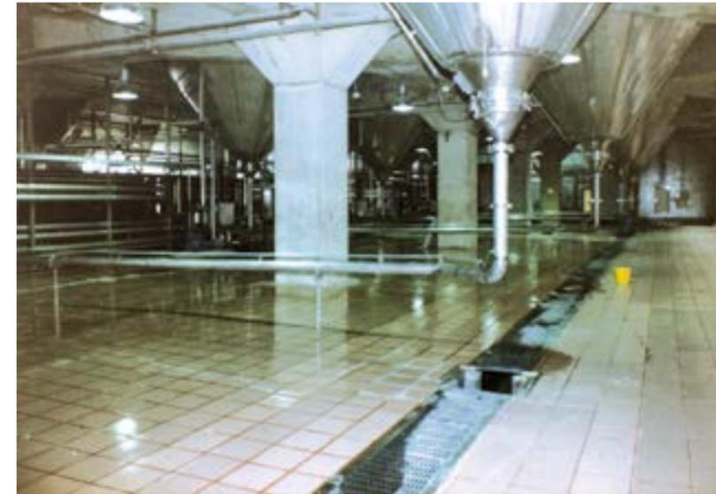
Existe la alternativa de aplicar un sistema de pisos poliméricos sobre tabletas de gres ó cerámicas. Para ello se deberá tener una superficie sana, limpia y seca, no deberán haber tabletas sueltas o con humedad en sus juntas.
