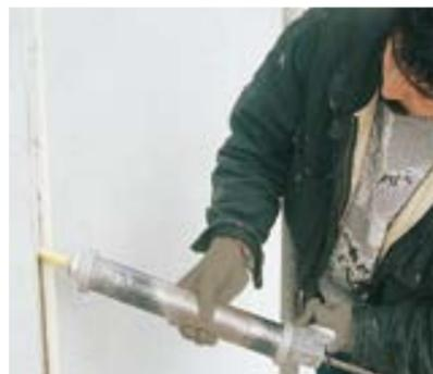
autonivelante. En zonas donde la cantidad de metros lineales de junta es menor se puede usar **Sikaflex®-401 Pavement SL**. En áreas de proceso, si se presenta algún tipo de ataque químico, se recomienda utilizar una masilla elástica del tipo **Sikaflex®-PRO 3**. (Ver tabla de resistencia química en su Hoja Técnica).
