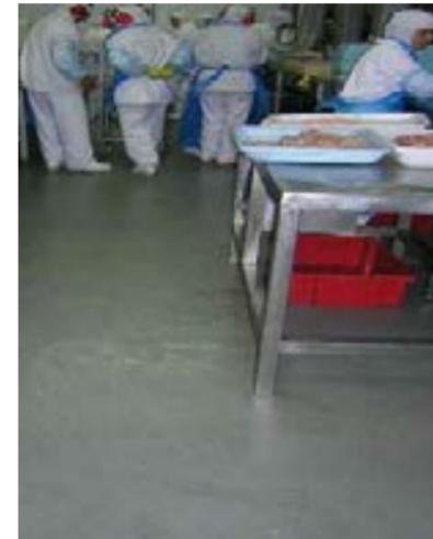
Solución mate o Glossy con tecnología de mortero a base de resinas de poliuretanos base agua y cemento **Sikafloor® PurCem** ó **Sikafloor®Purcem Glossy** que es un mortero rico en resina, de color uniforme, fácil de aplicar, de tres componentes. Esta diseñado para dar una excelente resistencia a la abrasión, al impacto, al ataque químico, al ataque térmico y a otras agresiones físicas. Dependiendo del tipo acabado puede ser:
