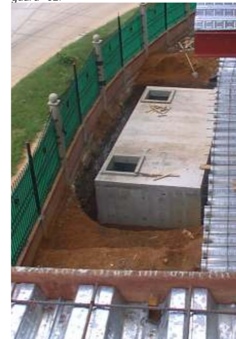
Tanque para depósito de agua
