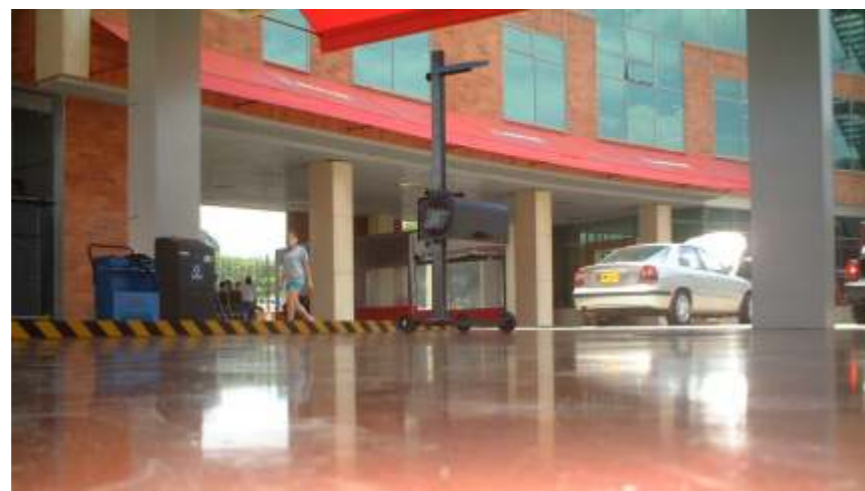
Pisos endurecidos en zonas de inspección
