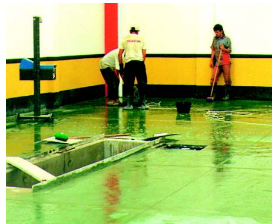
Zonas donde se utilizó el endurecedor de pisos Sika Chapdur Neutro y Rojo
