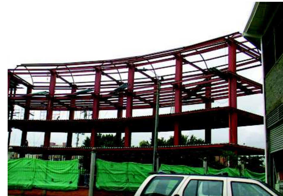
Estructura metálica protegida con Esmalte Epóxico Serie 33 e imprimada con el Imprimante Epóxico Rojo
