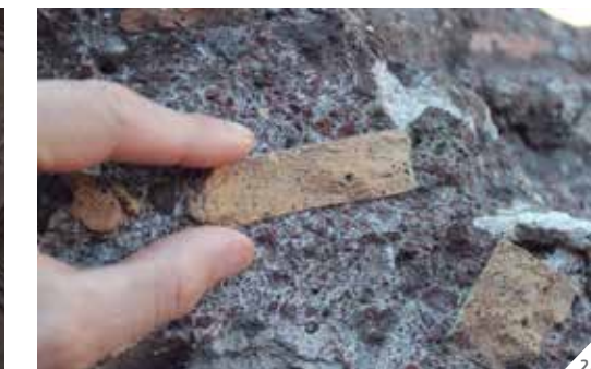
1. Cubierta de 43 m de luz del Panteón - Roma (125 d.c.) Foto del Autor. 2. Opus Caementitium - Coliseo Romano - 80 d.c. Foto del Autor. 3. Teatro de Ostia Antica - 12 a.c. Foto del Autor.
