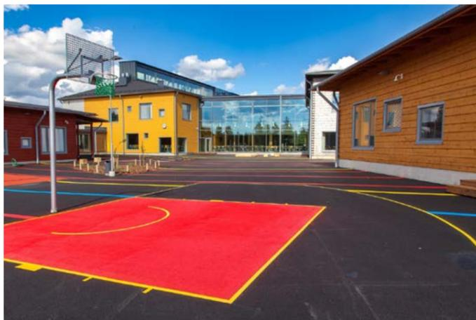
del secado, se aplicó una capa superficial mate no amarillenta Sikafloor®-304 W en la parte superior con resistencia a los rayos UV. El personal de las instalaciones realmente aprecia el sistema de pavimento y comentando que “sus piernas no se sienten cansadas después de un día de trabajo, realmente se siente la elasticidad.”
