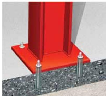
Anclajes estructurales, bases metálicas
