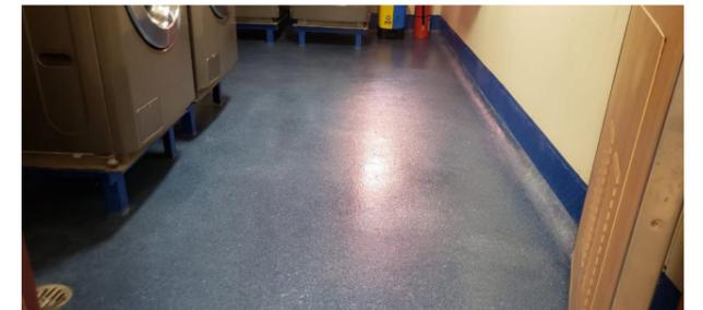
Finalmente se aplicó en estas juntas el **Sikafloor® Marine 530 Deco Black**, realizando un lijado en sentido vertical para lograr la apariencia de madera.
