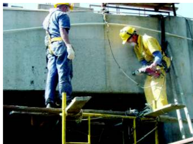
Figura 2. Limpieza y preparación de la superficie de las vigas aéreas.
