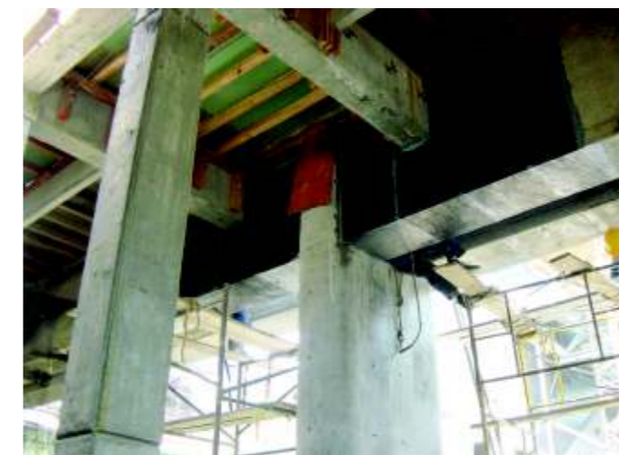
Figura 3. Colocación del tejido de fibra de carbono SikaWrap 300C.
