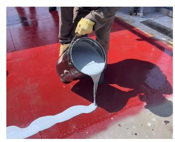
Posteriormente, se aplicó el **Sikafloor®-161** a razón de 0.4 kg/m², el cual es un imprimante epóxico de 2 componentes, de baja viscosidad, excelente adherencia, y fácil aplicación para ser usado en todo tipo de climas, recomendado como base para el **Sikalastic®-720 One Shot**.
