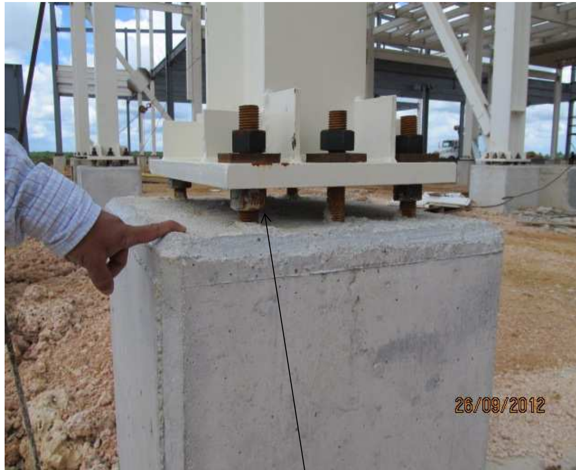
En la Base de las Estructuras Metálicas (SikaGrout 212)
