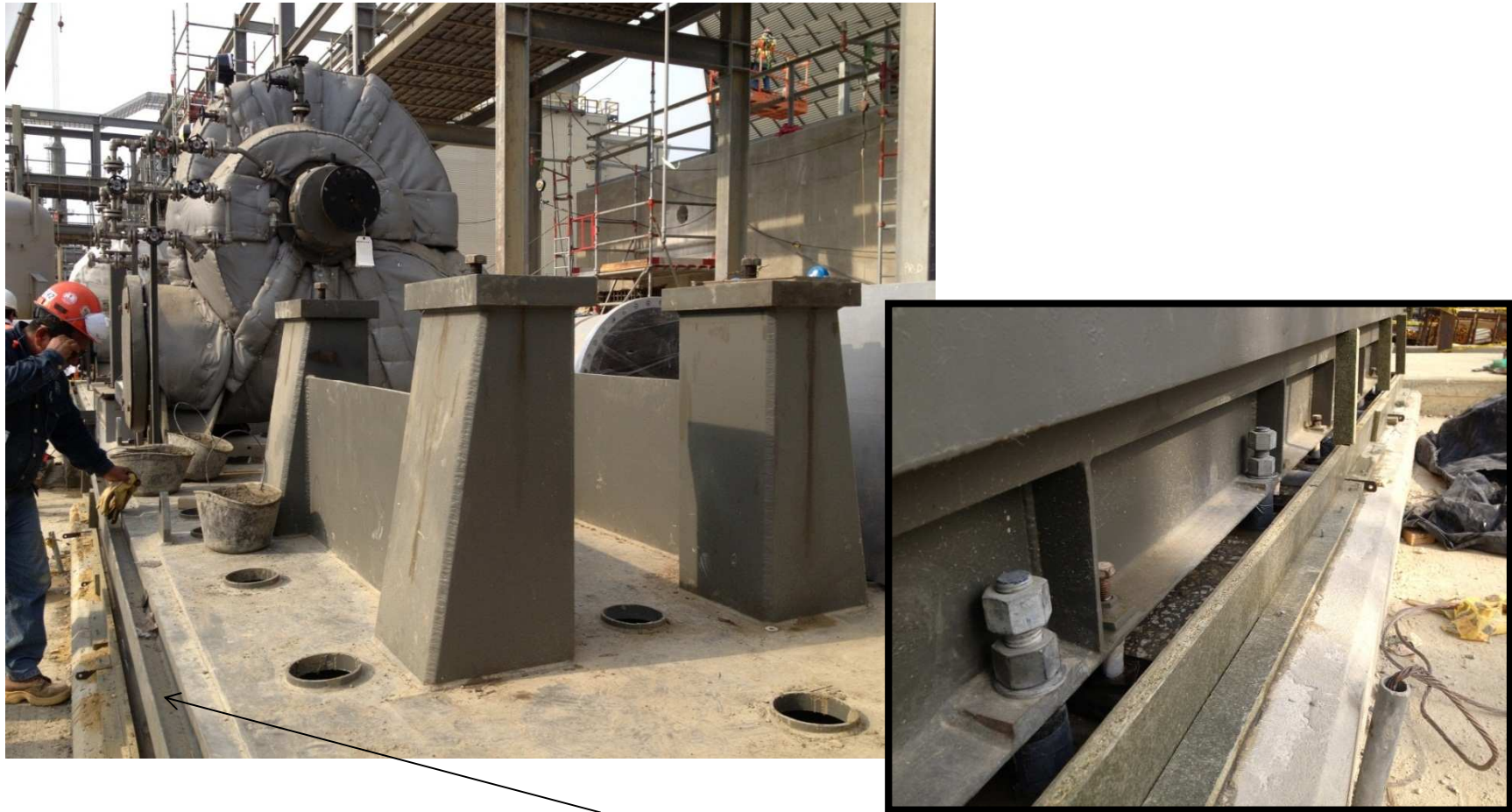
En la Base de las Estructuras Metálicas (SikaGrout 212)
