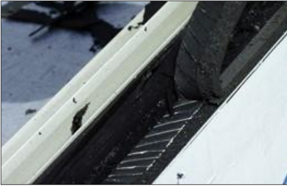
Figura 31: Ejemplo con la unión del SG negro - Buena adhesión.
