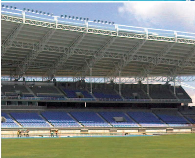
Se utilizaron los morteros de reparación **SikaTop®-121** y **Sikalisto®Piso** en la reparación de las graderías del estadio y la espuma de poliuretano expansiva **Sika®Boom** como un relleno de las juntas entre las mamposterías y la estructura de concreto.
