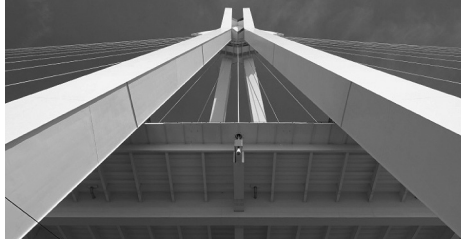
PROTECCIÓN DE LA CORROSIÓN
