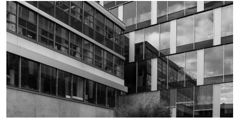
PEGADO Y SELLADO DE FACHADAS
