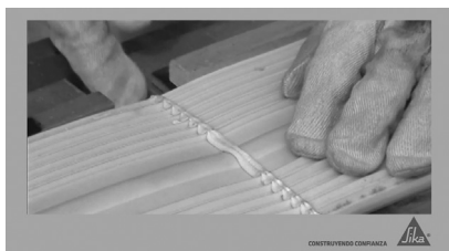
Emplee un paño para limpiar el exceso de PVC después de cada soldadura.
