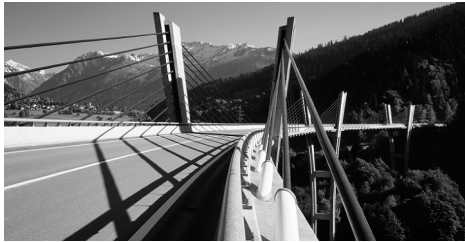
REPARACIÓN Y PROTECCIÓN DE CONCRETO
