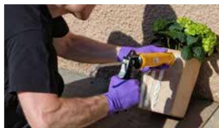
3. Asegúrese de aplicar suficiente adhesivo, dependiendo de las condiciones del sustrato y el peso del elemento a instalar.
