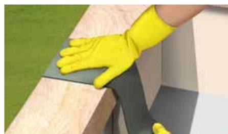
3. Retire el papel protector e instale la cinta presionando con la mano hasta que se haya fijado bien.
