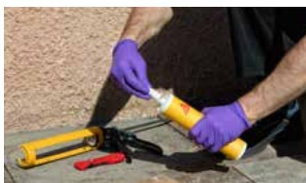
1. Corte la boquilla en V e inserte el cartucho en la pistola.
