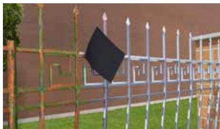
1. Lijar la superficie metálica para eliminar óxido, grasa o mugre. Limpiar la superficie con Colmasolvente Alquídico Sika (solvente).
