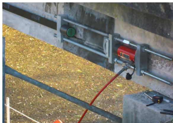
Foto 20 . muestra una platina de carbono postensada Sika®CarboDur® S626 en la parte lateral de una de las vigas en el reforzamiento de un puente en Francia.
