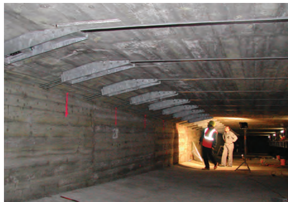
Foto 18 . Interior de la viga cajón de un puente en Suiza. Se ven las platinas de carbono y el extremo móvil (zona donde se hace el tensionamiento de las platinas de carbono).
