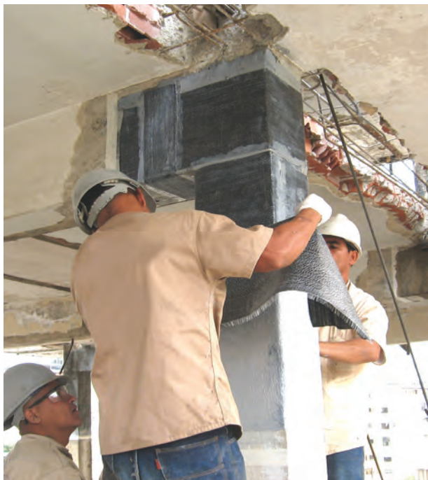
Foto 8. Reforzamiento sísmico de un nudo exterior de una edificación con un laminado de fibra de carbono, SikaWrap® 300C .
