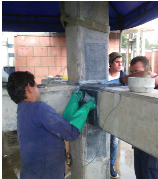
Foto 9. Nudo de concreto reforzado, a escala real, siendo reforzado con un laminado de fibra de carbono SikaWrap® 300C y el cordón de fibra de carbono SikaWrap® FX-50C . Tesis de la Escuela Colombiana de Ingeniería (2017). Cortesía Ing. Andrés Ramírez.
