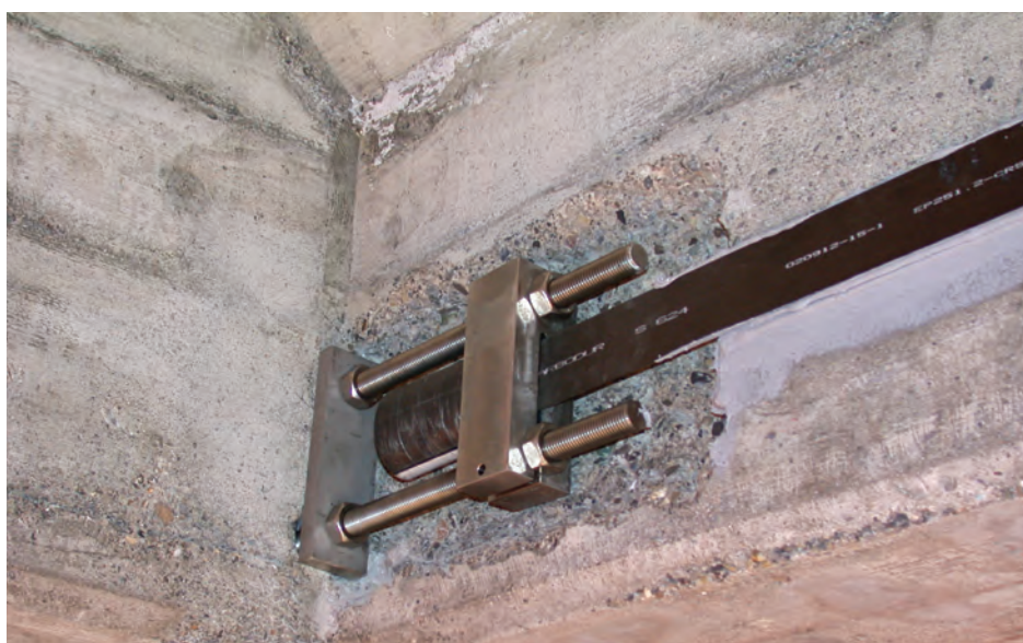
Foto 21. (a superior) Platina de carbono en la parte lateral de una viga de un puente en Suiza. (b inferior) Detalle del anclaje de la platina de carbono postensada.
