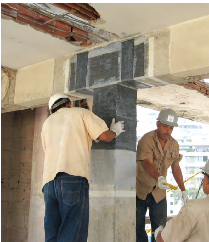
Foto 4. Reforzamiento de los nudos de un edificio con un laminado de fibra de carbono, SikaWrap® 300C .
