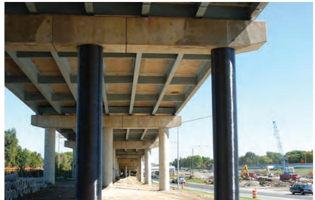
Foto 2. Reforzamiento de las columnas en un puente con un laminado de fibra de carbono SikaWrap® , para mejorar su comportamiento sísmico.
