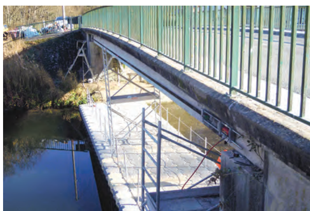
Foto 19. Vista lateral de un puente en Francia reforzado con las platinas de carbono tensionadas (parte lateral de las vigas).
