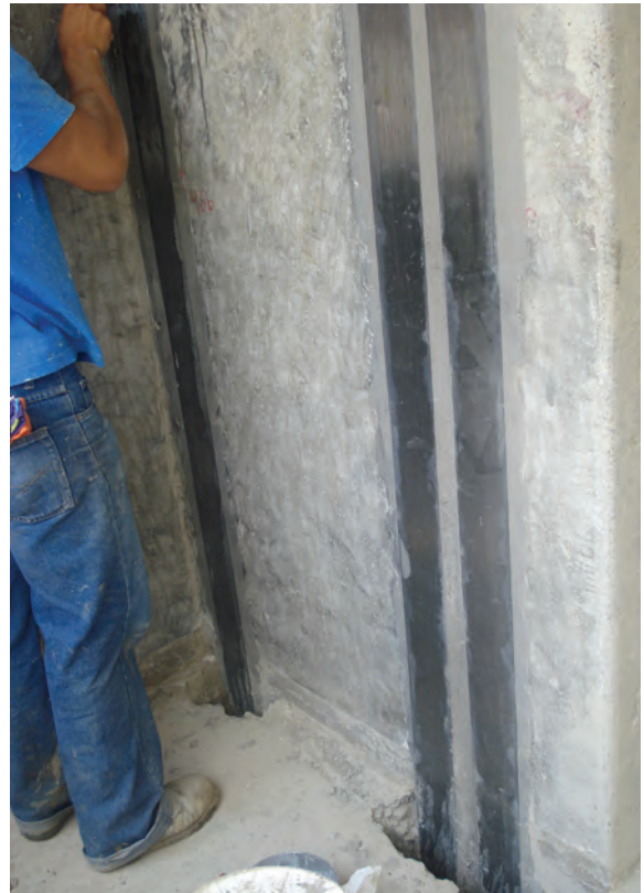
Foto 11. Reforzamiento de una pantalla de concreto reforzado con las platinas de fibra de carbono Sika® CarboDur® S1012 .
