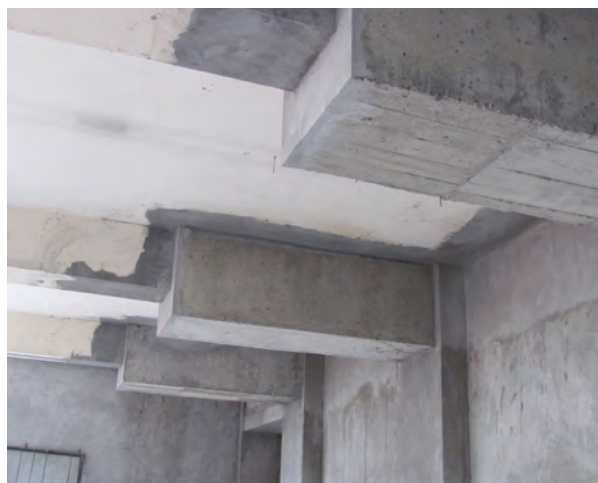
Foto 3. Recrecimiento con concreto reforzado de las vigas que conforman los nudos (unión viga – columna) en un edificio.
