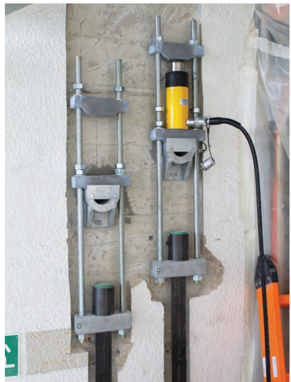
La foto 16. Extremo móvil del sistema de platinas de carbono postensadas Sika®CarboStress®
