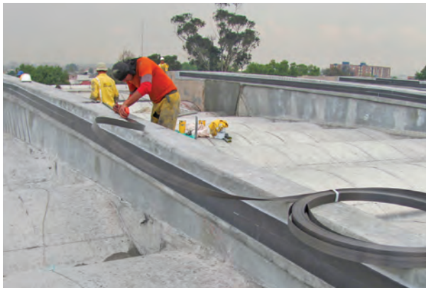
Foto 1. Colocación de platinas de fibra de carbono Sika®CarboDur® en las vigas en voladizo del techo de una estructura (estadio de fútbol) para mejorar su desempeño sísmico.
