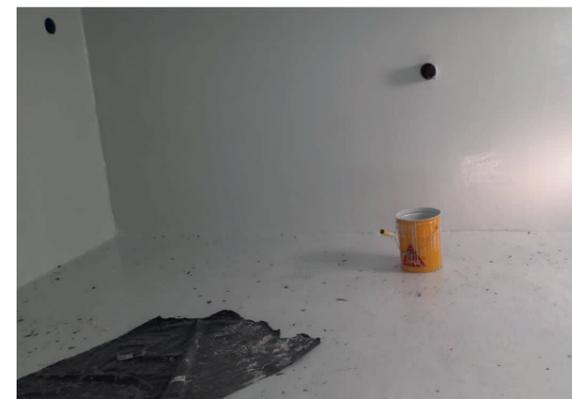
con llana y para detalles con brocha. Para hacer un puenteo de posibles fisuras en los vértices, se reforzaron estas esquinas colocando Sika Refuerzo Tejido, malla de fibra de vidrio, en medio de dos capas de **Sikalastic®-1K**.
