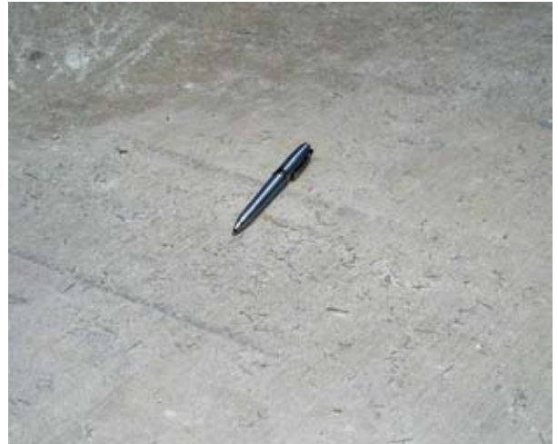
Foto No. 10: Concreto adicionado con fibras para la construcción de andenes y vías.
