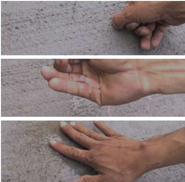
Foto No. 9: Sello de grietas por retracción plástica antes de que el concreto fragüe.
