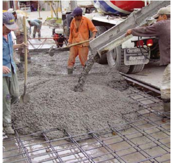
Foto No. 5 Empleo del concreto de alta resistencia inicial (Fast Track) para elaboración y rápida puesta en servicio de una vía.
