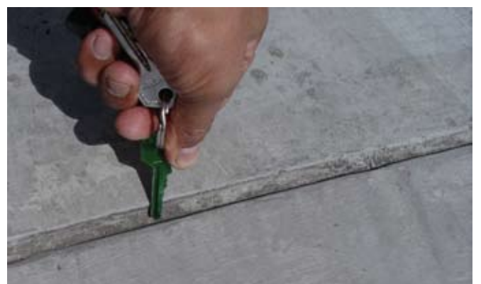
Foto No. 12: Aparentemente existen juntas de dilatación/contracción en esta estructura, pero no trabajan debido a su escasa profundidad.
