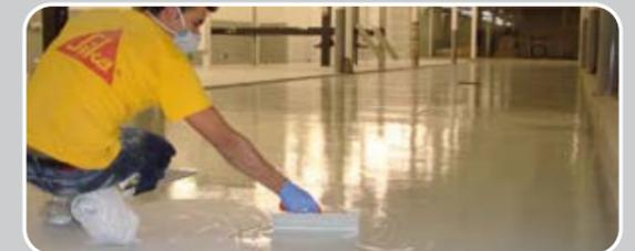
Aplicación de un mortero autonivelante con llana dentada
