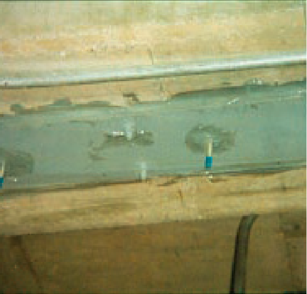
Platina metálica con anclaje auxiliar y pega con adhesivo epóxico inyectado en viga
