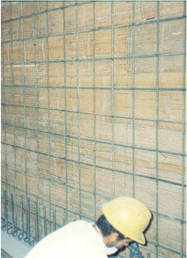
Muro de cortante dentro del edificio
