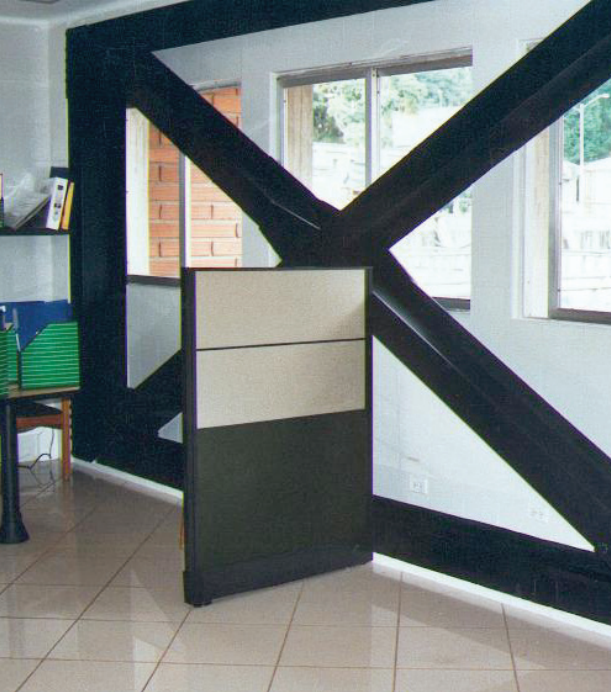
Marco metálico con conexión indirecta en edificio industrial
