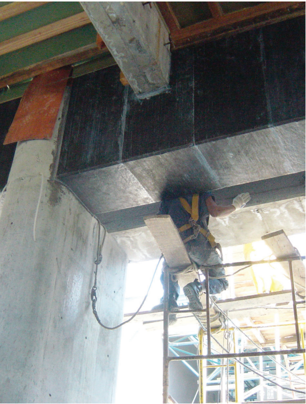
Figura 26. Encamisado o envoltura con laminas o platinas CFRP, GFRP, AFRP en reforzamiento de columnas.
