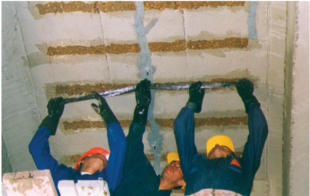
Inyección epóxica y láminas CFRP en losa de puente
