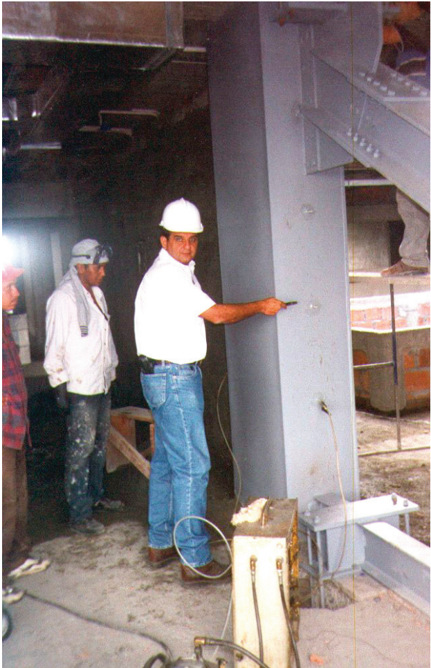
Encamisado de columna con láminas metálicas con relleno eóxico inyectado.
