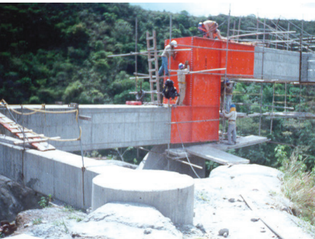
Láminas metálicas en nudo en viga cajón en concreto con relleno epoxico inyectado
