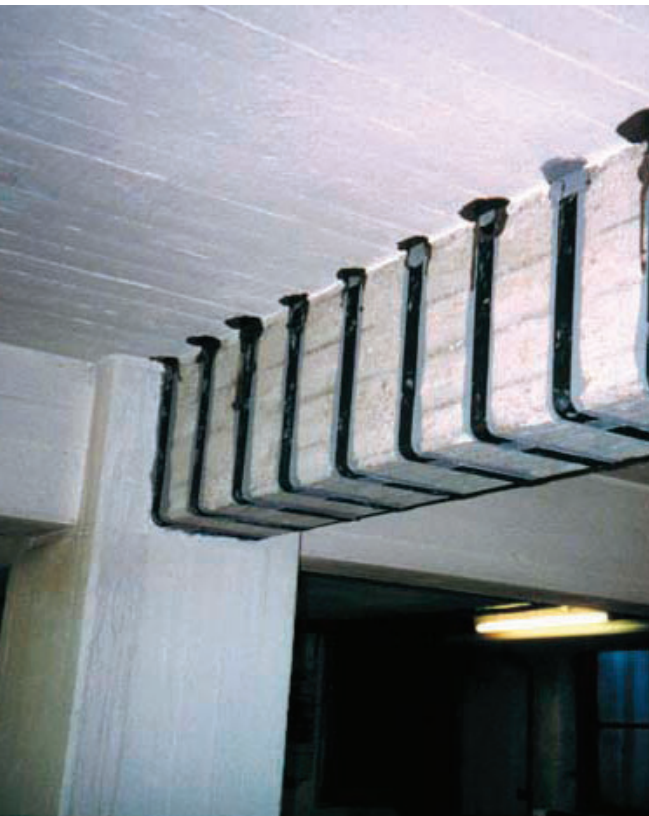
PlatinasCFRP en L en viga y ancladas en losa
