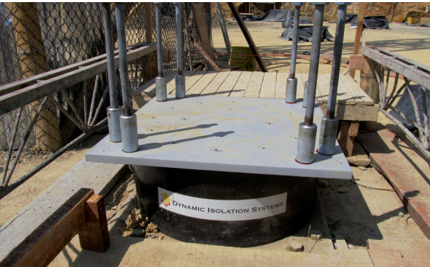
Aisladores en edificio (Colombia)
