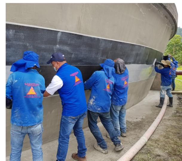
Para la instalación de los tejidos de fibra de carbono **SikaWrap®-600C** se realizó limpieza de la superficie, retirando el mortero y removiendo toda clase de suciedad, lechada, grasa, polvo y en general cualquier material o partícula suelta o extraña que impida la adherencia de los productos utilizados para la instalación del tejido.
