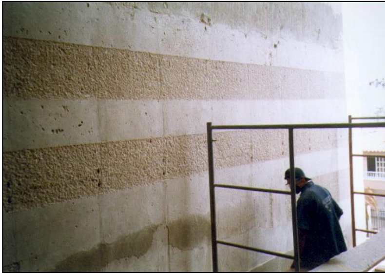
Preparación de superficie
