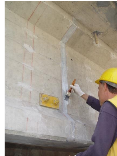
Imprimación de la superficie con el adhesivo epóxico Sikadur 301
