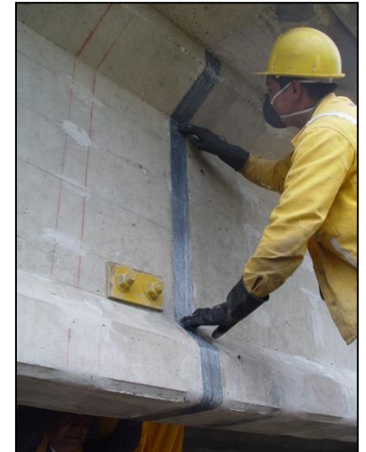
Colocación del tejido de fibra de carbono SikaWrap 600C
