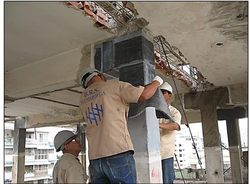
Nudos reforzados con SikaWrap 300C
