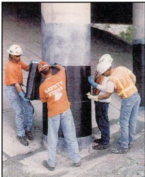
Colocación del SikaWrap Hex 103C
