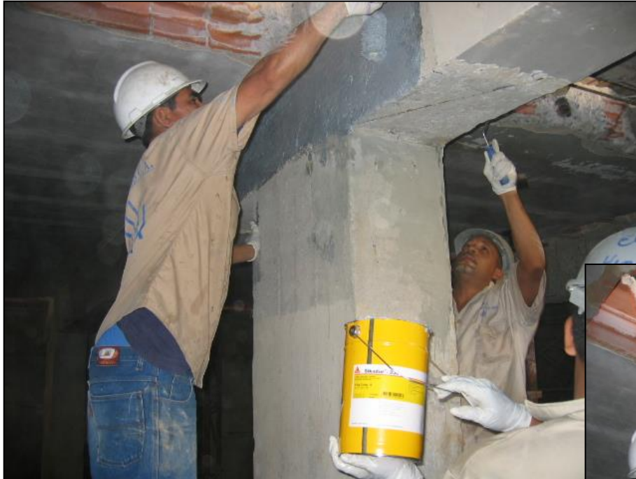
Imprimación de la superficie con el adhesivo SikaDur 301
