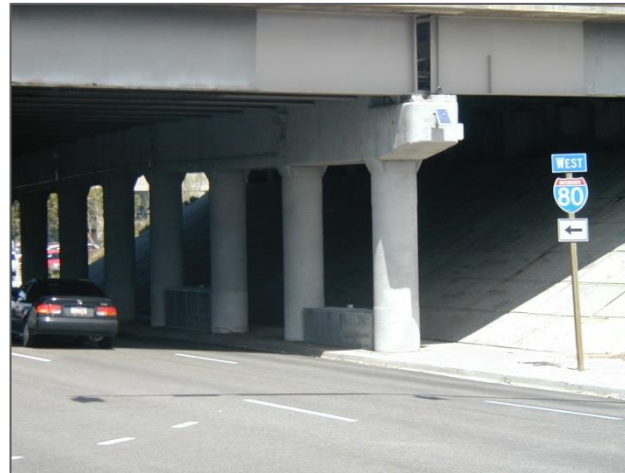
Colocación del SikaWrap Hex 103C
