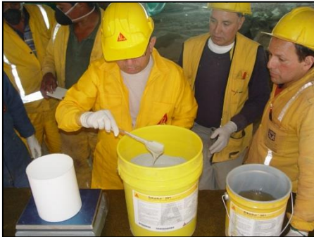
Mezclado del adhesivo epóxico ( Sikadur 301 )
