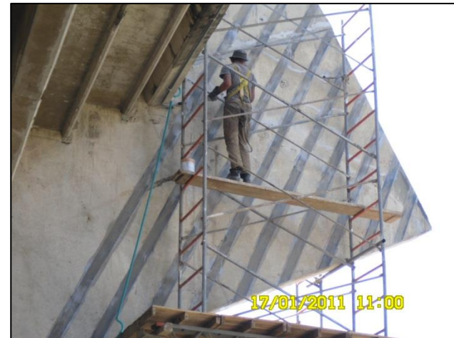
Colocación del SikaWrap 600C
