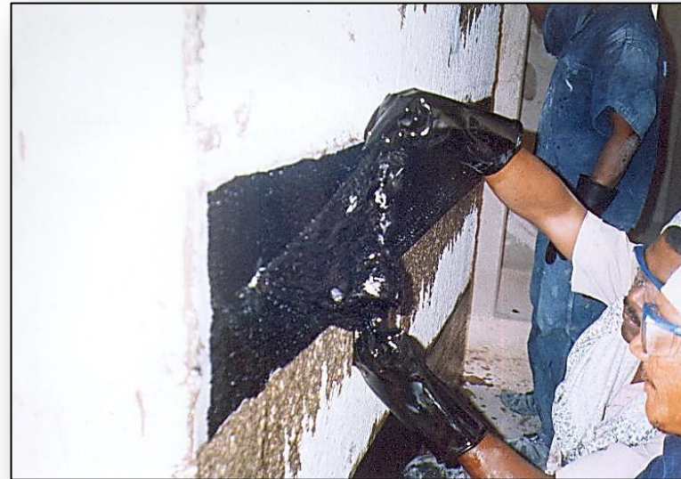
Colocación del SikaWrap 600C
