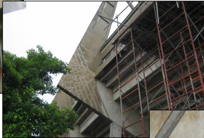
Inyección de las fisuras con una resina epóxica de baja viscosidad Sikadur 35 Hi Mod LV
