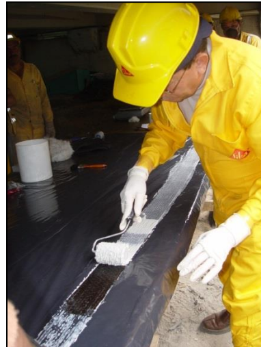
Impregnación del tejido de fibra de carbono con el adhesivo epóxico Sikadur 301
