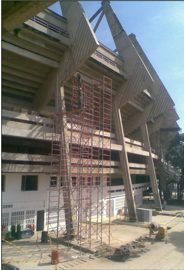
Andamios en los 56 codos aguja
