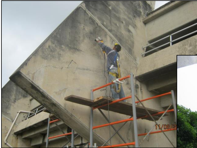
Limpieza de los codos aguja
