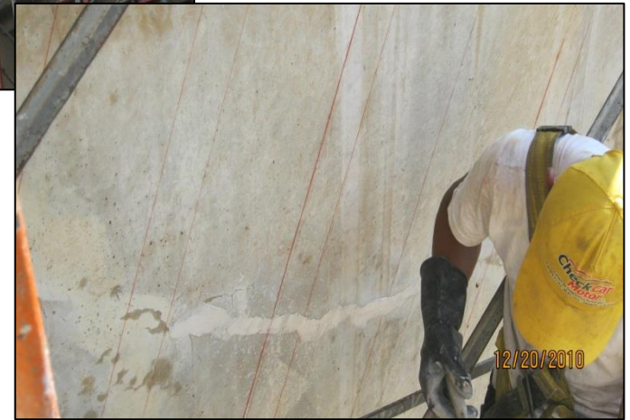
Demarcación de las tiras de fibra de carbono
