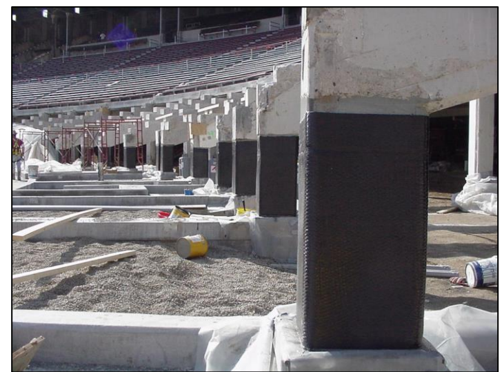
Colocación del SikaWrap Hex 103C
