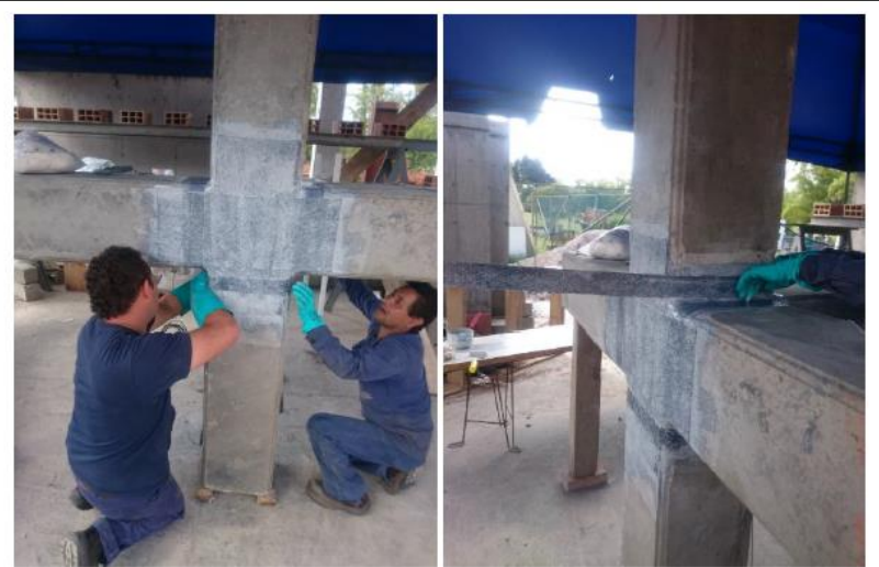
c) Colocación de las fibras
