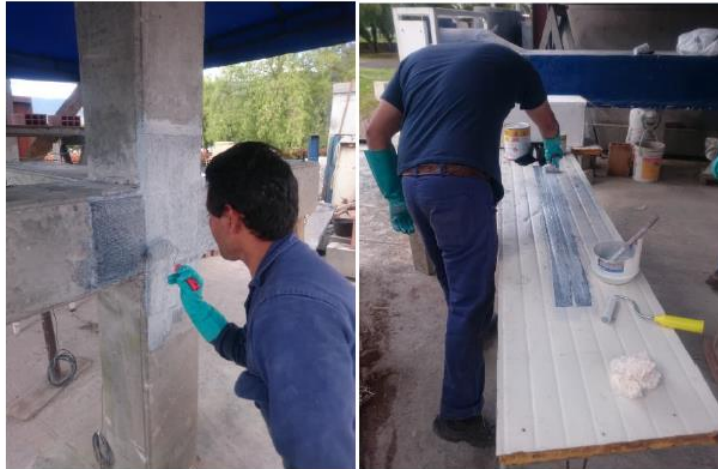
a) Impregnación de la superficie
