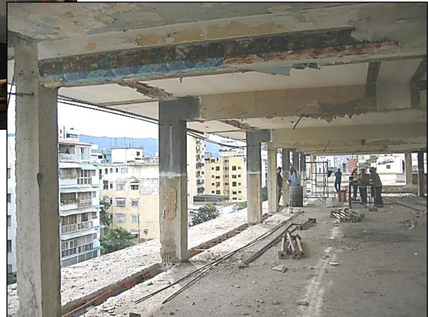
Nudos reforzados con SikaWrap 300C
