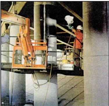
Colocación del SikaWrap Hex 103C
