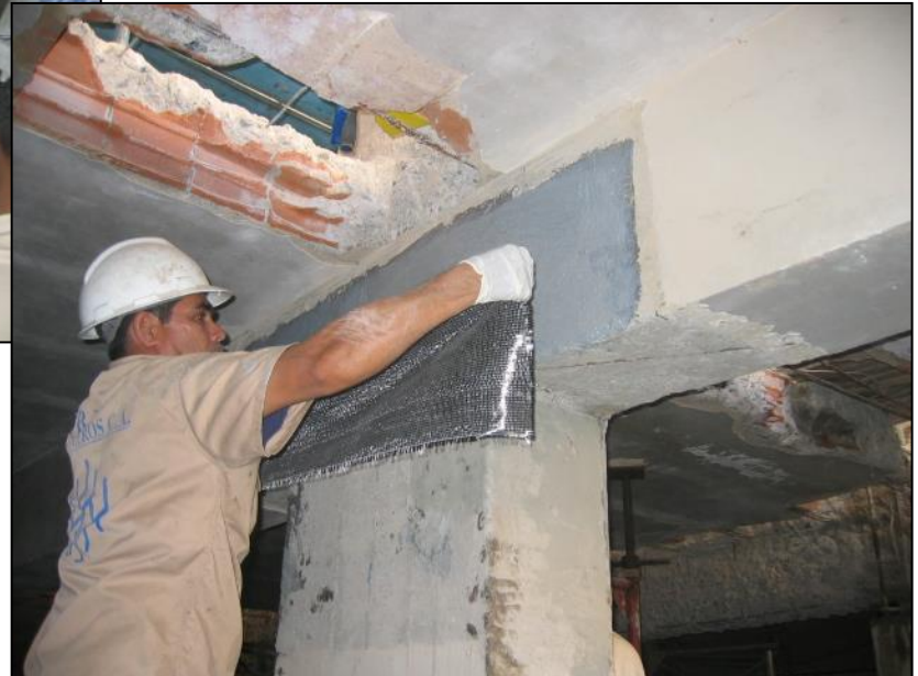
Instalación del tejido de fibra de carbono SikaWrap 300C
