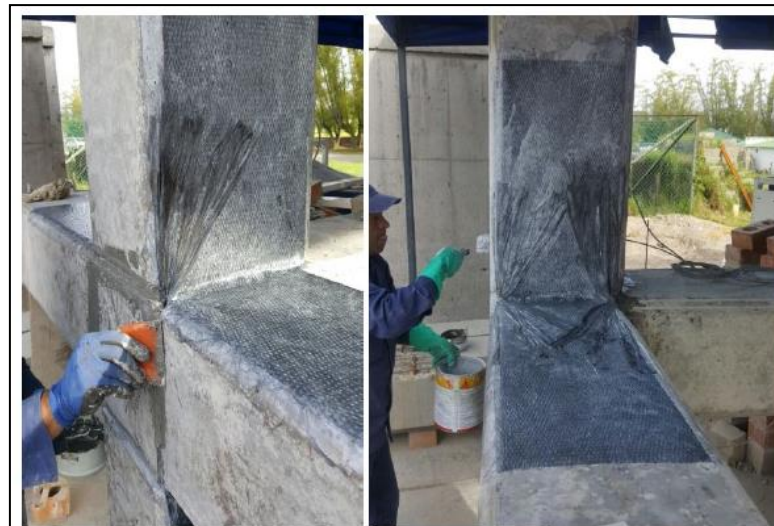
d) Colocación de los cordones
