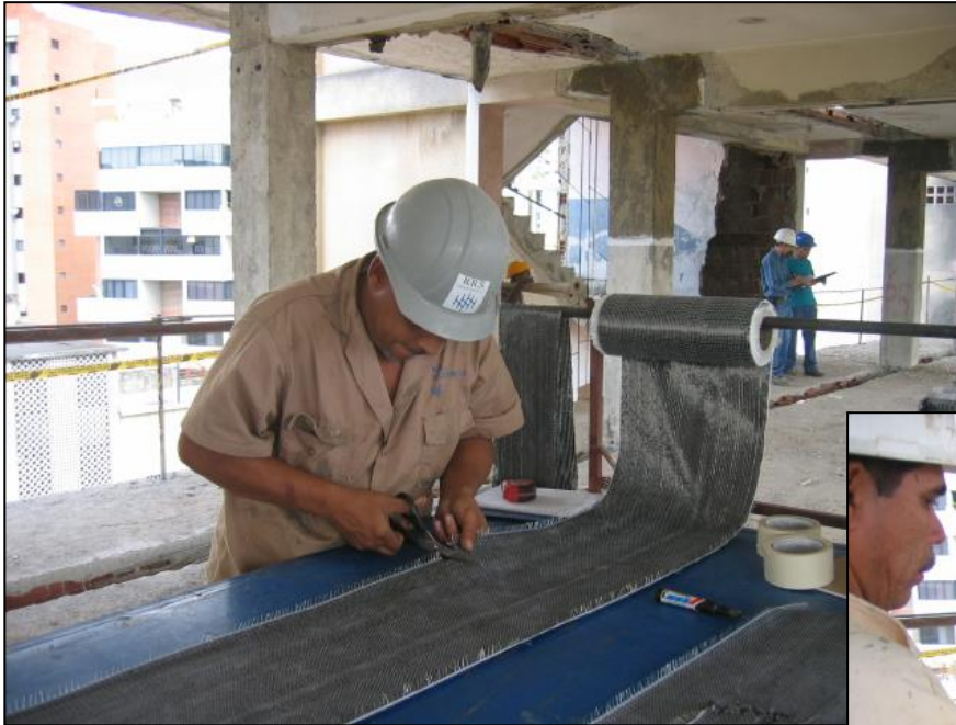
Corte del tejido de fibra de carbono SikaWrap 300C
