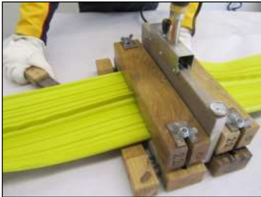
La plancha de las cintas de PVC (Sika Waterbars)
