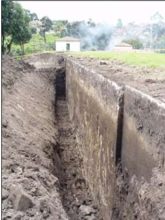
Tanque de agua potable Vitelma – Bogotá (2005)
