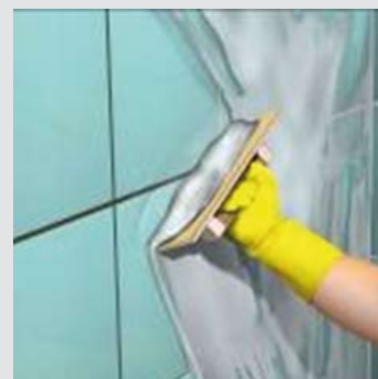
Emboquillado con Binda Boquilla Acrilico
