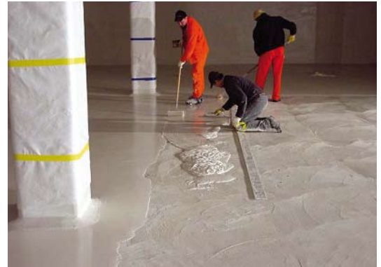
Aplicación de un mortero autonivelante para la impermeabilización de la losa de un tanque. Nótese la facilidad de la aplicación. ( Sikafloor® Level 25 )
