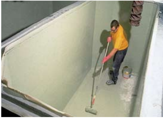
Recubrimiento de una cava en la industria con material epóxico aprobado para contacto con alimentos y bebidas ( Sikaguard®-62 ). Aquí no sólo la impermeabilidad, sino la asepsia juegan un papel de importancia.
