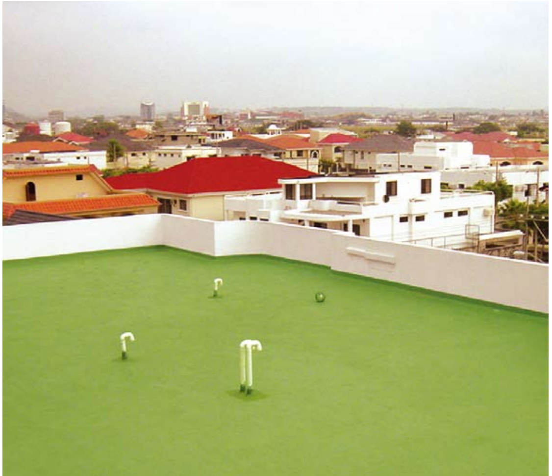
Cubierta impermeabilizada con un recubrimiento acrílico elástico. ( SikaFill10 Fibras )
