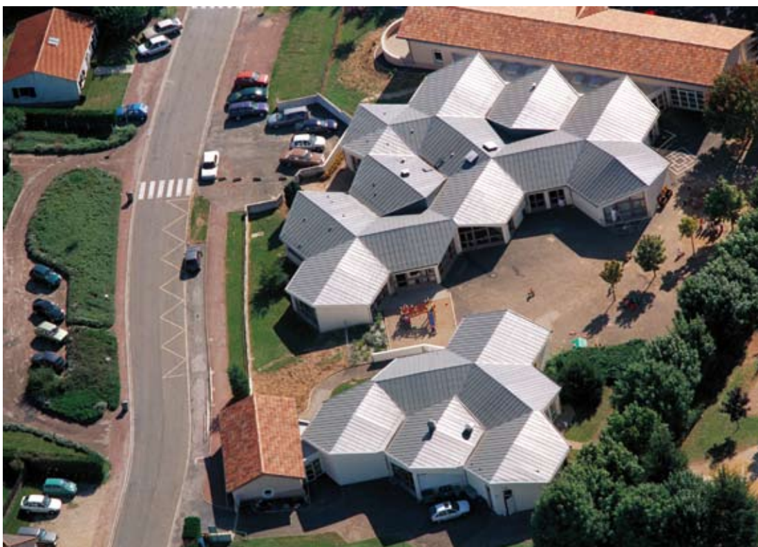
Techos de edificaciones destinadas a vivienda, impermeabilizados con membranas de PVC, resistentes a los rayos UV.
