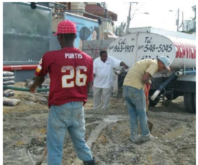
Dosificación del agua “al ojo” que puede generar problemas de resistencia y permeabilidad.
