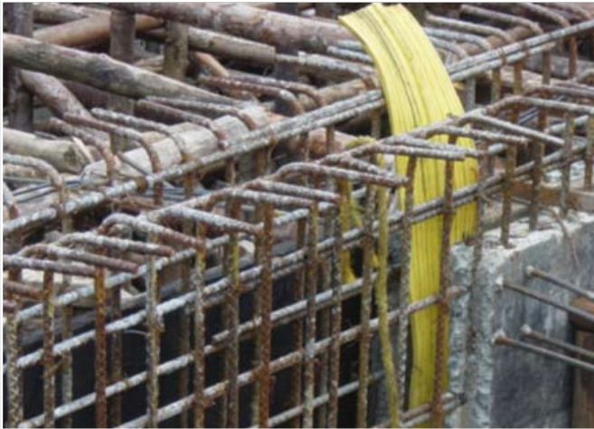
Detalle de la instalación de cintas de PVC en las juntas de construcción verticales y horizontales de un tanque.
