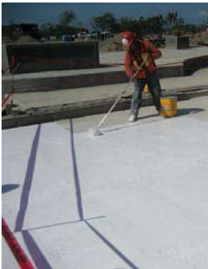
Facilidad y rapidez en la aplicación de una membrana líquida de poliuretano ( Sikalastic® 450 )
