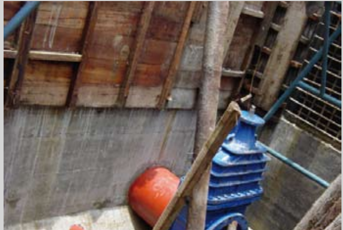
Especial atención debe prestarse al paso de tuberías en los tanques, para que el mismo proceso constructivo no genere un sitio por donde se fugue el agua.
