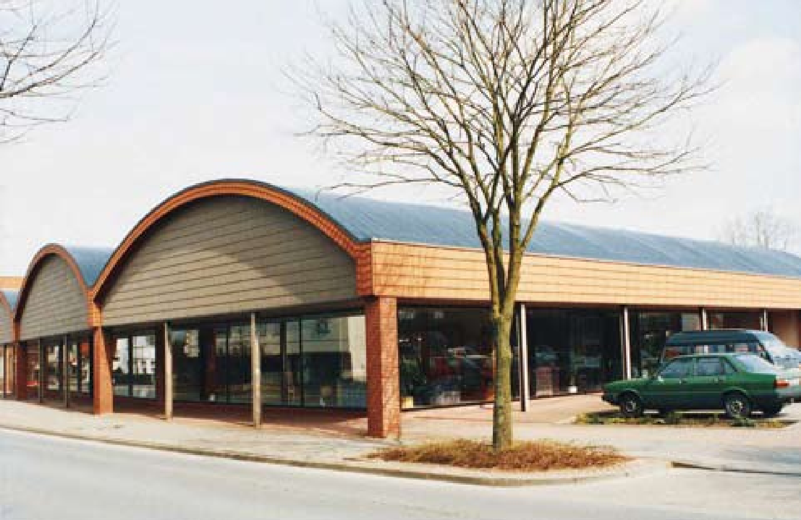
Cubiertas de un centro comercial elaboradas usando ladrillo para la construcción de arcos que luego fueron impermeabilizados con membrana de PVC ( Sikaplan ®) de alta resistencia a la intemperie.
