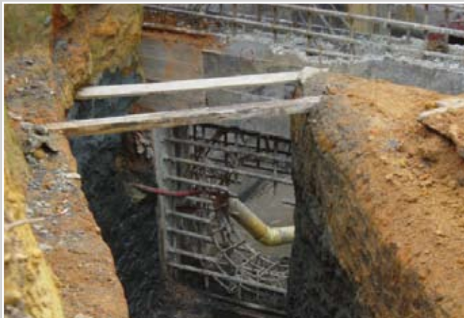
Especial atención debe prestarse al paso de tuberías en los tanques, para que el mismo proceso constructivo no genere un sitio por donde se fugue el agua.
