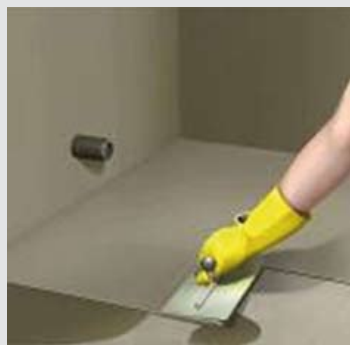
Plantilla impermeable con un recubrimiento asfáltico o un mortero impermeable predosificado
