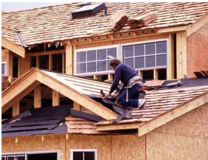
Instalación de membrana asfáltica sobre techos de madera, observar el sentido correcto de la aplicación de las capas.
