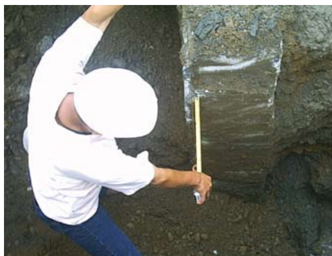
Construir las cimentaciones con concreto impermeable es el primer paso para controlar los problemas de humedad en la edificación.
