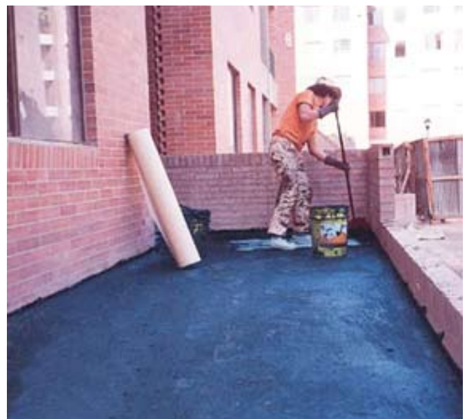
Aplicación de una emulsión asfáltica y refuerzo entre capas, en la impermeabilización de un balcón.
