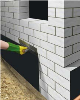
Impermeabilización de un muro, antes de colocar la tierra, con un recubrimiento impermeable de naturaleza asfáltica. ( Igol®Denso )
