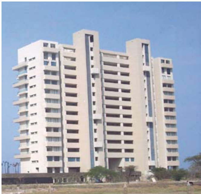
Fachada protegida con un recubrimiento acrílico impermeable. ( SikaColor®F )
