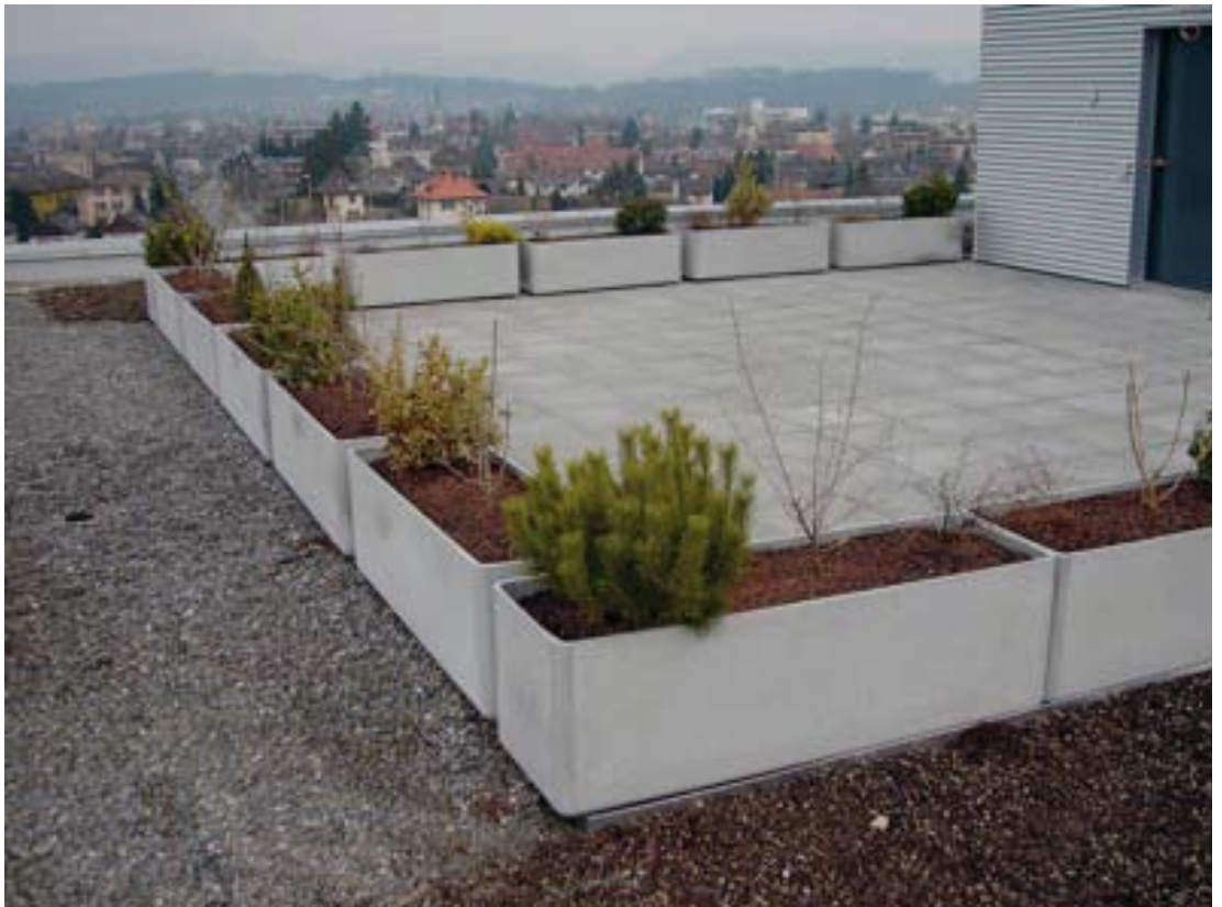
Terraza impermeabilizada con Sikaplan y protegida de los rayos UV con gravas. Este tipo de impermeabilización permite, como se ve en la foto, diseñar patios y jardines que agregan valor estético a la cubierta.
