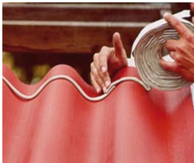
Sello del traslape entre tejas que evita la entrada de agua y polvo del exterior, muy útil esta solución en techos con poca pendiente donde el agua se devuelve.
