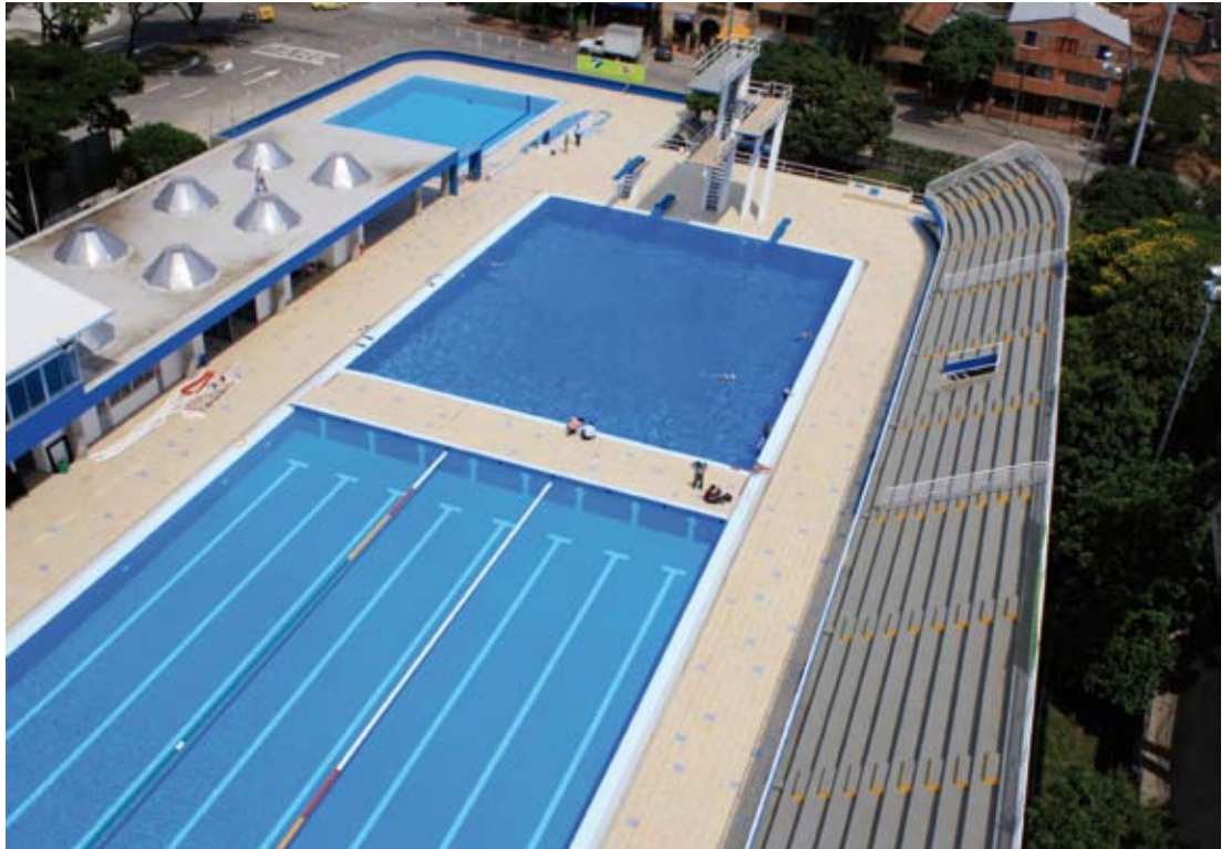
Vista de una piscina olímpica impermeabilizada con membranas de PVC.
