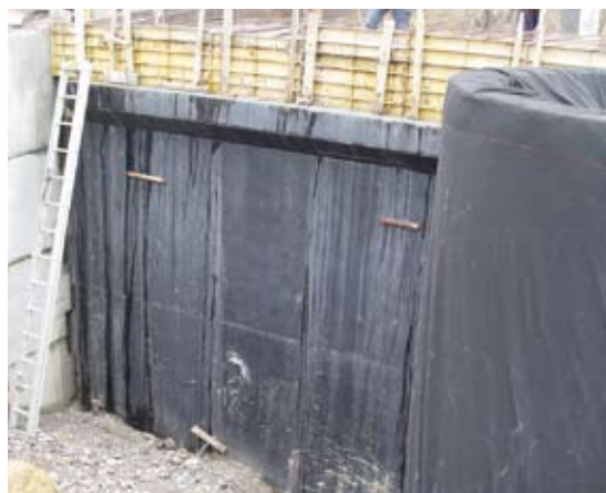
Aplicación de un recubrimiento asfáltico modificado que impide el paso de agua aún en forma de vapor. (Igol®Denso)
