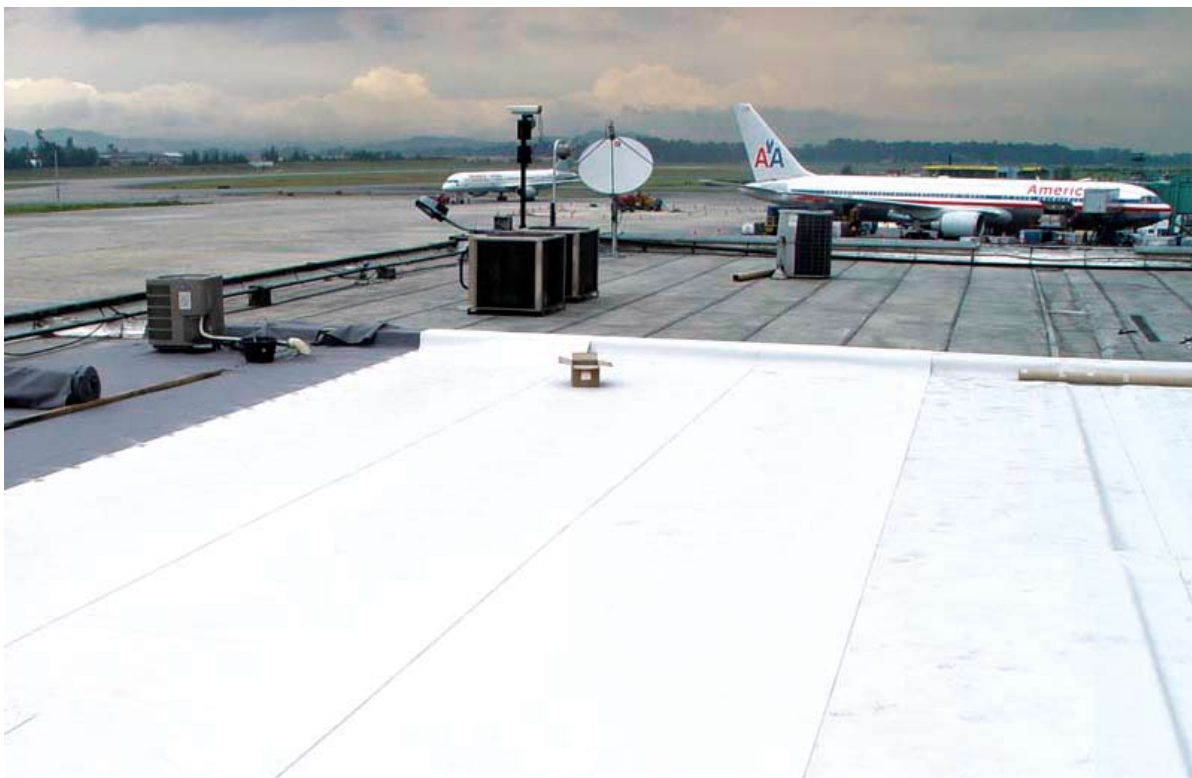
Impermeabilización con Sikaplan ® 12 G CO de las cubiertas en el área internacional del aeropuerto El Dorado
