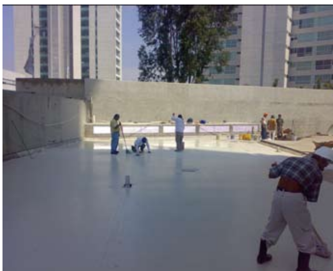
Aplicación de recubrimientos impermeables con base en poliuretanos ( Sikalastic® 450 ) para la impermeabilización de cubiertas.
