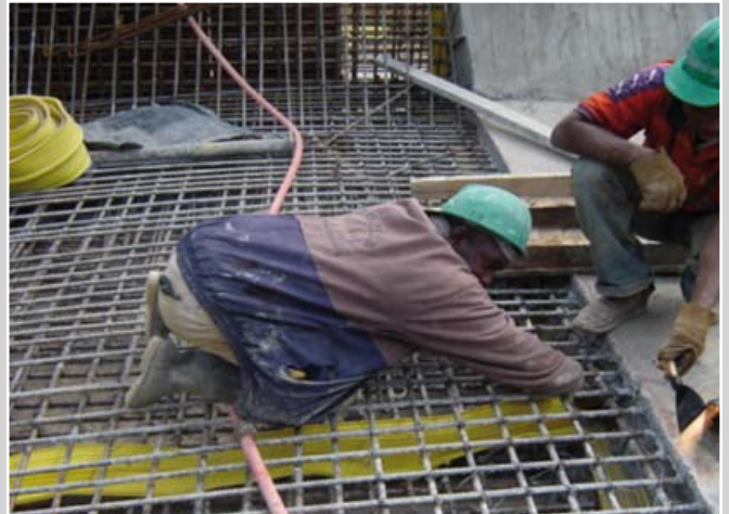
Detalle de la instalación de cintas de PVC en las juntas de construcción verticales y horizontales de un tanque.
