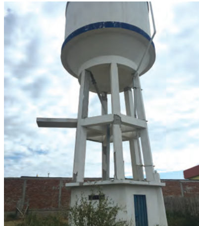
Tanque elevado dañado durante el sismo de Ecuador de Abril 16 de 2016.
