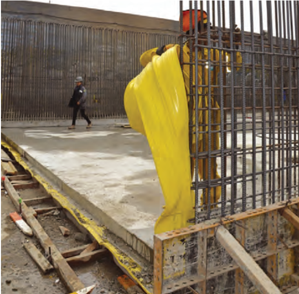
Cinta de PVC colocada correctamente en la losa, conformando una junta de construcción.
