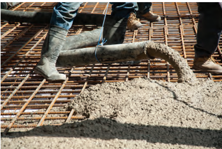
Colocación del concreto de una losa de una estructura para contener líquidos.
