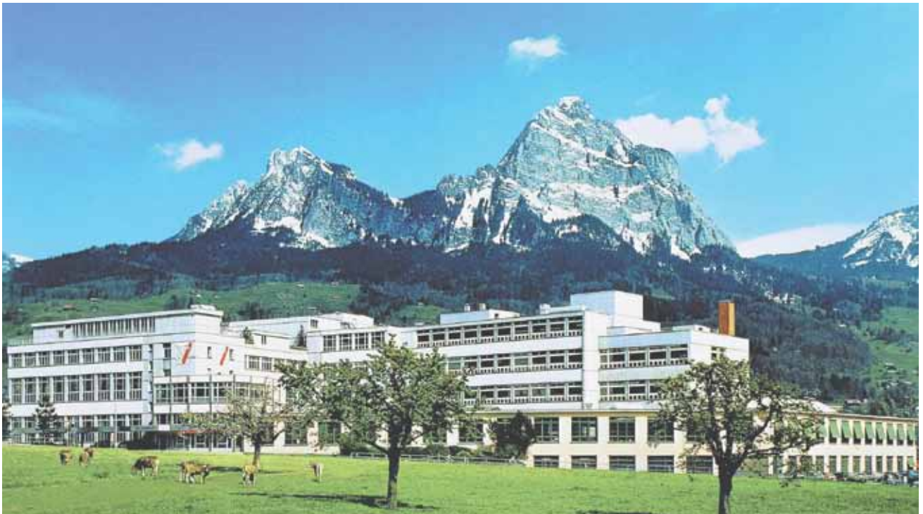
Oficinas centrales de Victorinox en Suiza, Sarnafil S327, 1978
