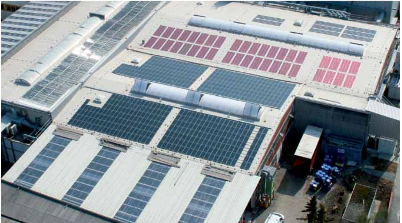
Parque solar Sika en Stuttgart, Alemania
