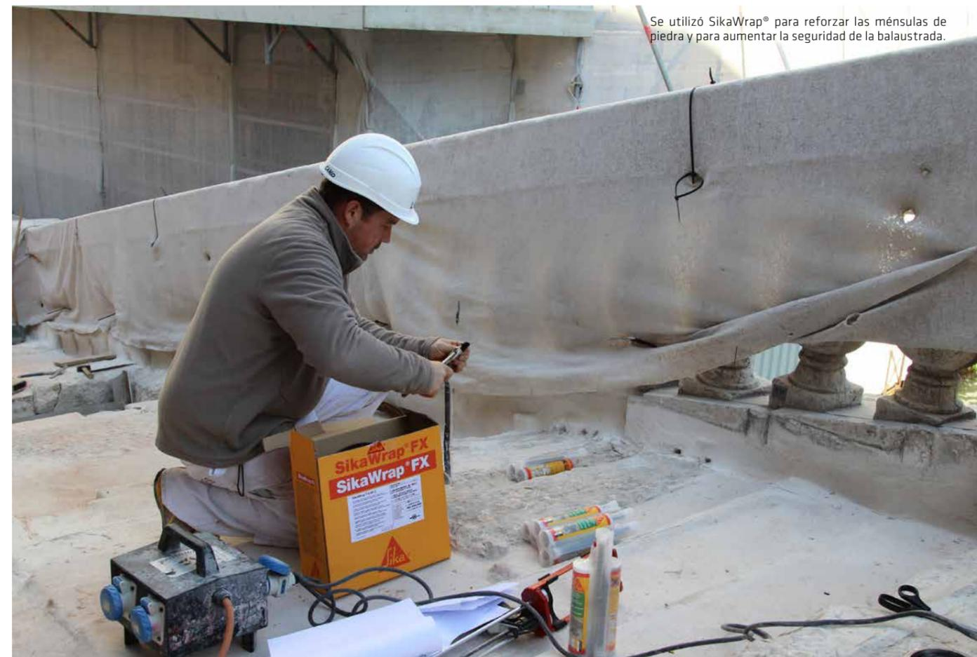
Se utilizó SikaWrap® para reforzar las ménsulas de piedra y para aumentar la seguridad de la balastrada.
