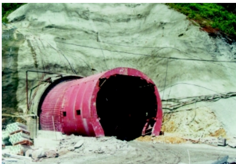
■ Construcción del revestimiento definitivo - Portal de salida
