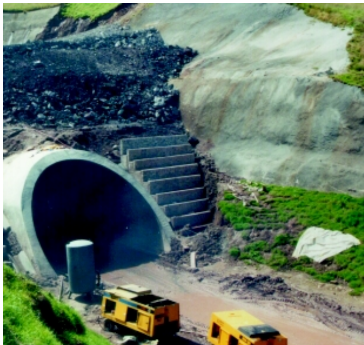
■ Construcción del falso túnel - portal de entrada
