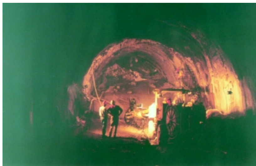
■ Frente de excavación
