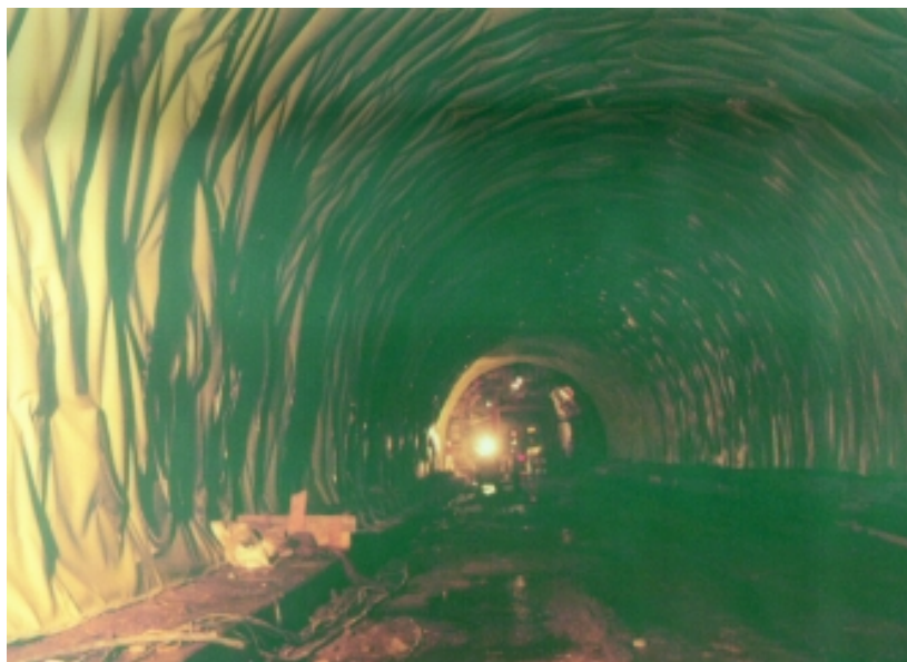
■ Colocación de la geomembrana
