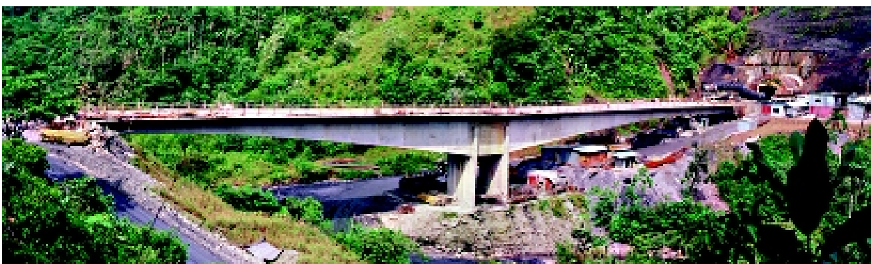
■ Viaducto Bijagual, une al tunel Buenavista con el Bijagual (en construccion).
