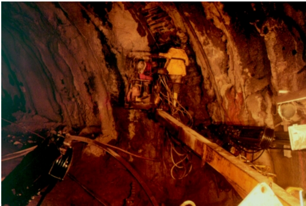
■ Inyecciones en el frente de excavación
