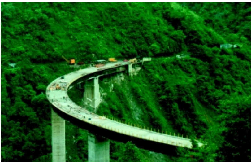
■ Viaducto de Chirajara
