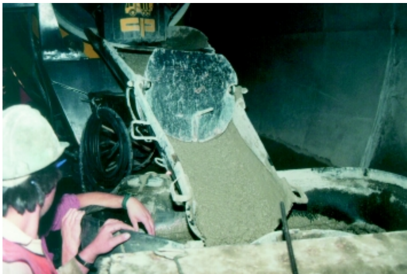
■ Bombeo del concreto de revestimiento
