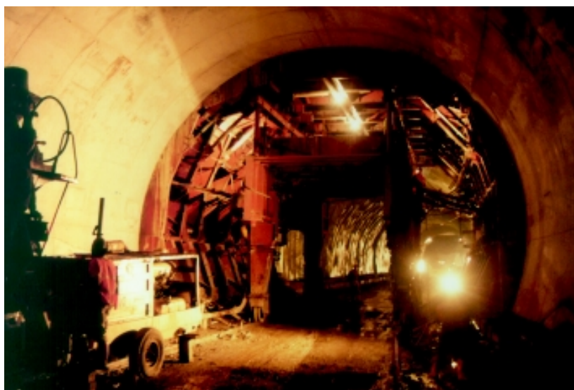
■ Vaciado del concreto de revestimiento
