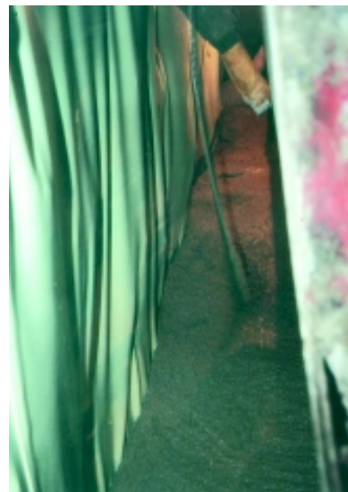
■ Concreto en el interior de la formaleta
