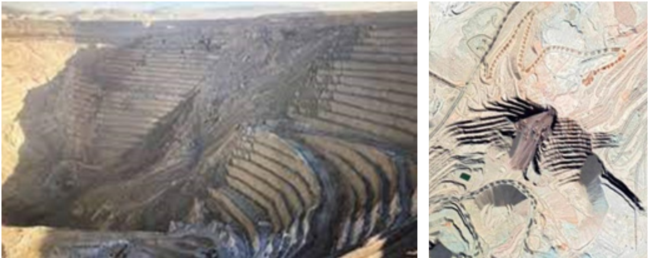
Fotografías 1. Colapsos minas cielo abierto debido a sistemas de fallamientos presentes y/o caída de roca inestable
