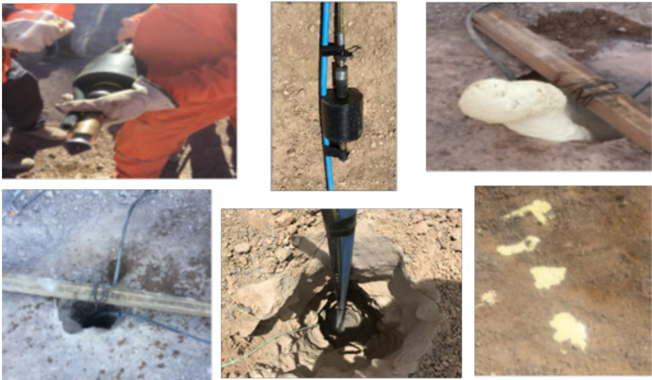
Fotografía 4. Instalación de Packer u obturador inflexible dentro de la perforación e inyección de la resina tipo SIKAFIX® en el interior del barreno para su escurrimiento a través de las fracturas existentes y lograr cohesión en el sector tratado.
