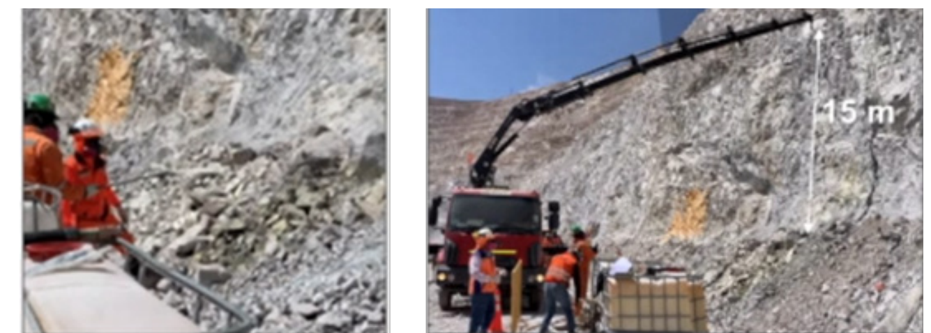
Fotografía 9. Proyección de resina SIKAFIX®602CL en forma manual y mecanizada para sostenimiento exterior de los taludes
