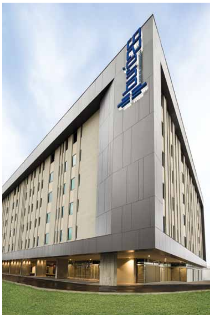
Hotel Buró 26 en Bogotá. Fachada Ventilada
