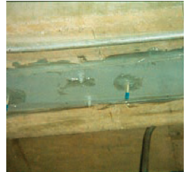
Platina metálica con anclaje auxiliar y pega con adhesivo epóxico inyectado en viga
