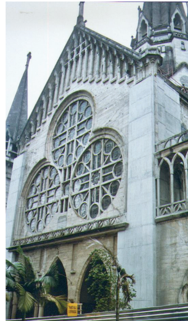
Engrosamiento de muros de concreto en iglesia
