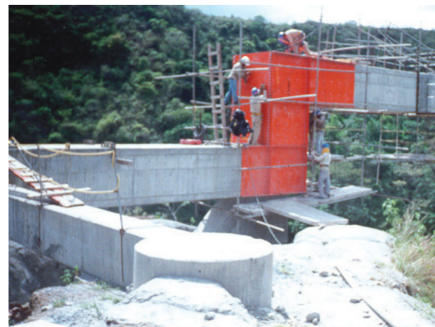
Láminas metálicas en nudo en viga cajón en concreto con relleno epóxico inyectado
