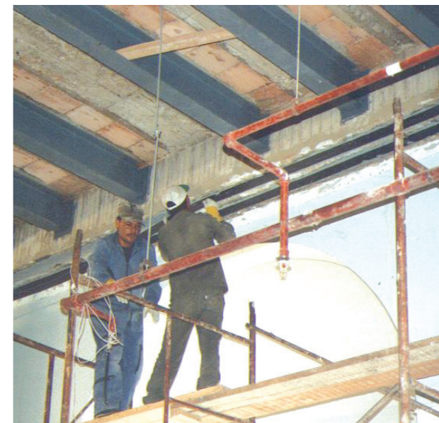
Adición de perfiles metálicos en losa y pega de platinas CFRP en vigas de edificio comercial
