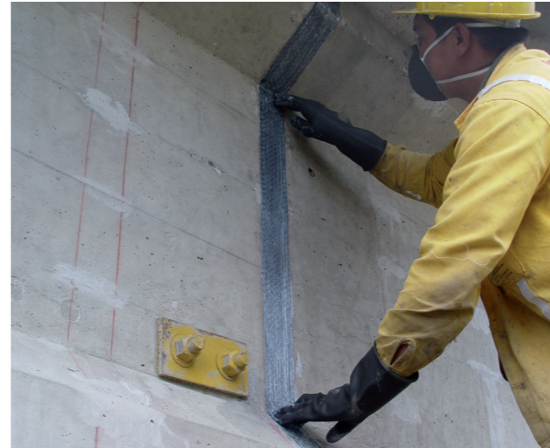
Láminas de CFRP en vigas I de puente
