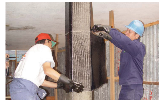
Envoltura de columnas en toda la altura con láminas CFRP en edificio
