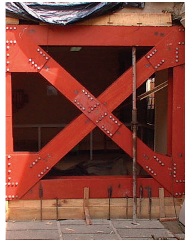
Encofrado de marco metálico para vaciado de concreto de baja retracción en edificio.
