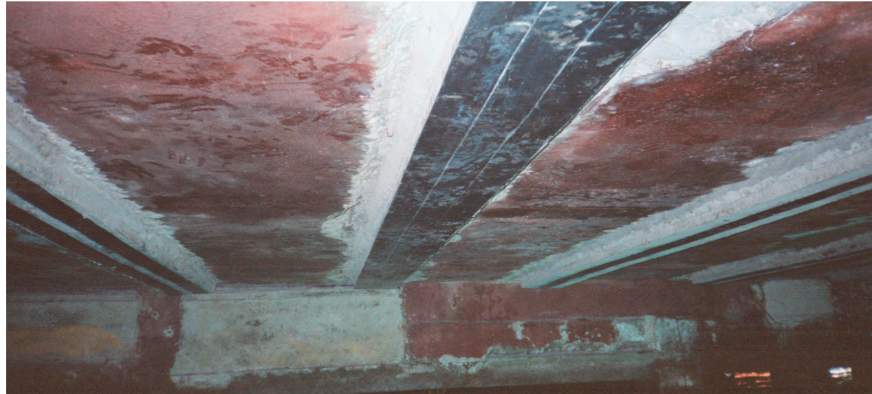
Engrosamiento local con concreto y platinas CFRP en losa pretensada de muelle
