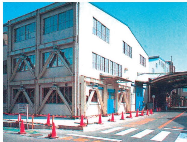
Adición de arriostramiento dúctil con panel de cortante, riostras y marco metálico (Japón)
