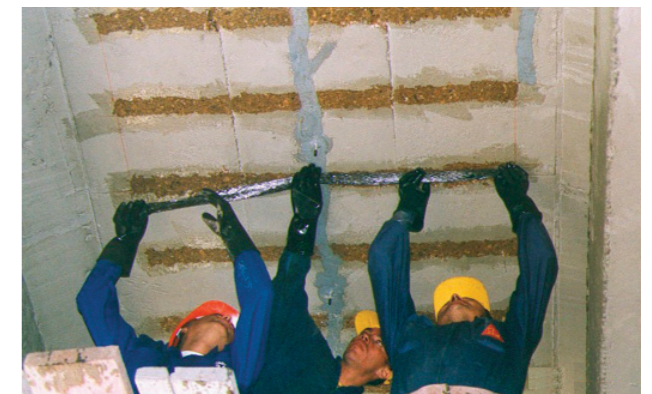
Inyección epóxica y láminas CFRP en losa de puente
