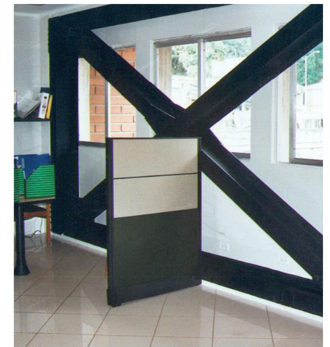
Marco metálico con conexión indirecta en edificio industrial
