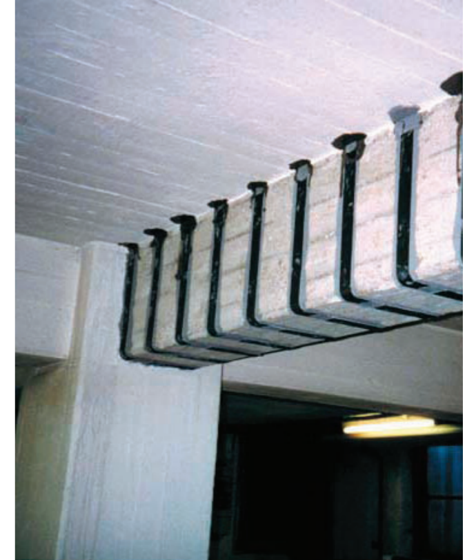
Platinas CFRP en L en viga y ancladas en losa
