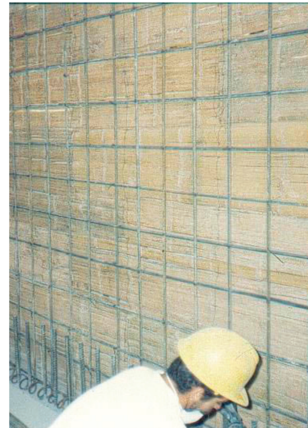
Muro de cortante dentro del edificio
