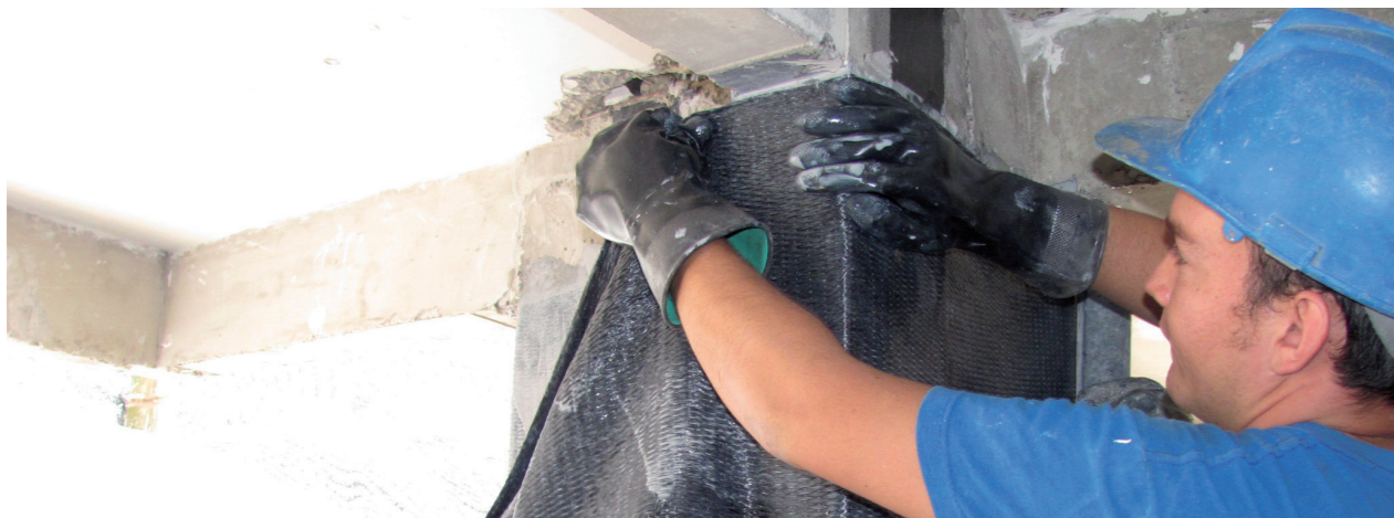
Láminas de CFRP horizontales en muro de cortante en edificio
