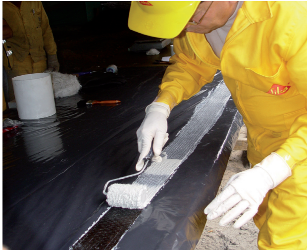
Colocación de la resina epóxica sobre la fibra de carbono
