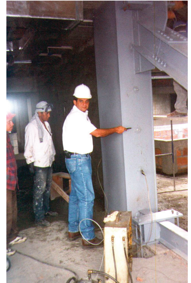
Encamisado de columna con láminas metálicas con relleno eóxico inyectado.
