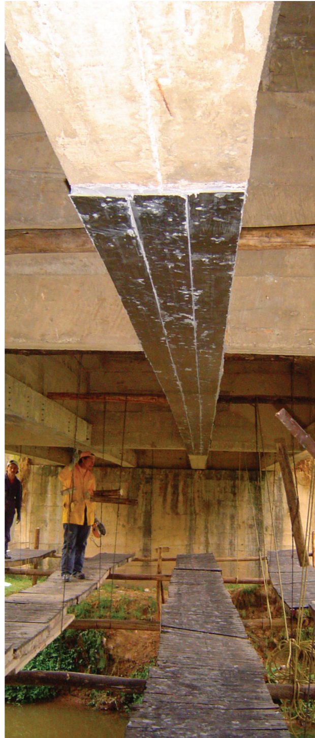
Platinas CFRP en vigas de concreto en puente
