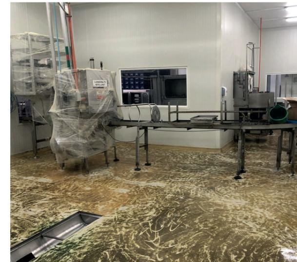
Por estos requerimientos se recomendó un mantenimiento con un recubrimiento que tuviera una excelente adherencia al poliuretano cemento y un rápido curado, siendo el **Sikafloor®-510** el producto ideal para este mantenimiento. Se tuvo en cuenta una excelente preparación de superficie por medios mecánicos a través de un destronado de la totalidad del
