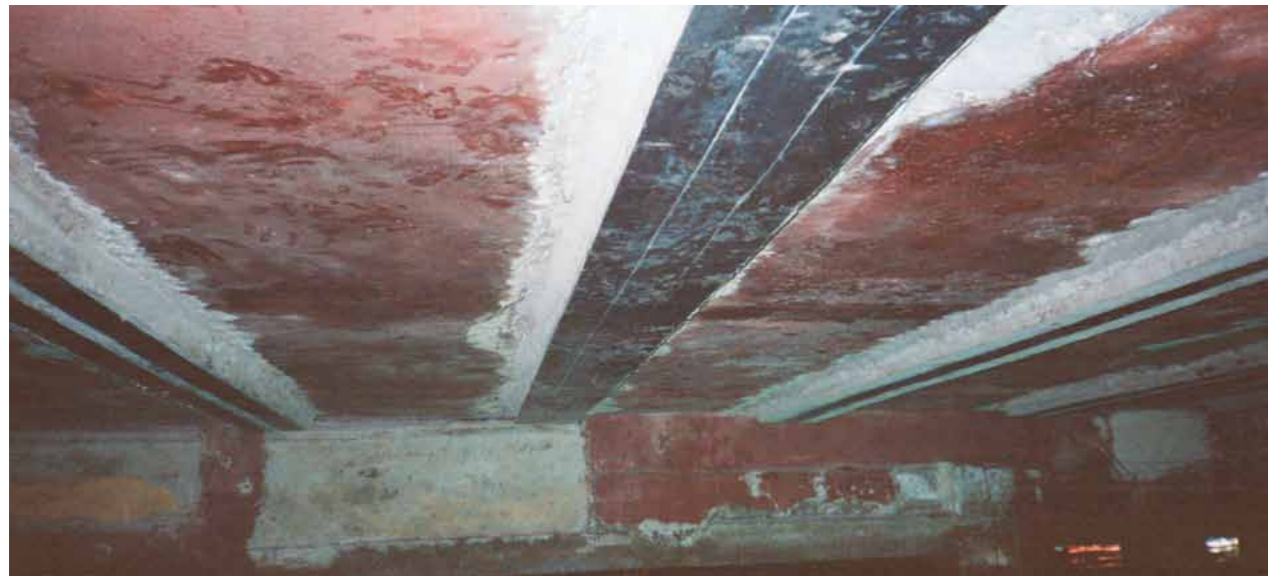
Engrosamiento local con concreto y platinas CFRP en losa pretensada de muelle
