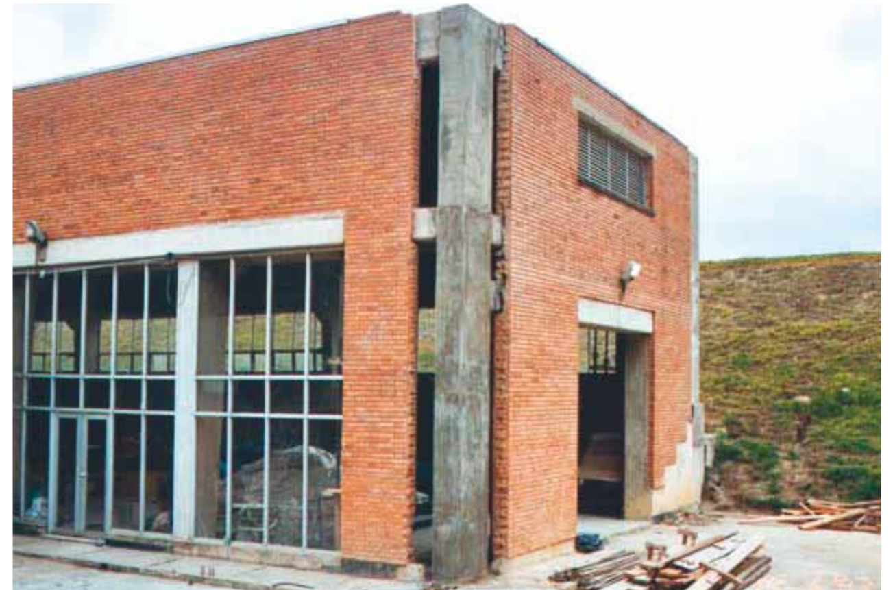
Encamisado de columna con concreto listo de baja retracción en edificio industrial
