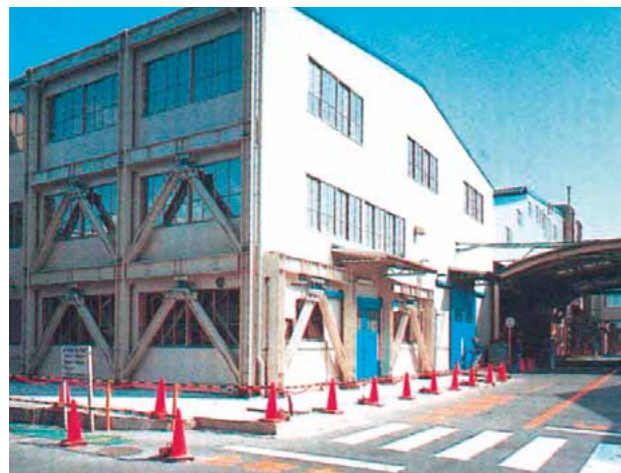
Adición de ariostamiento dúctil con panel de cortante, riostras y marco metálico (Japón)
