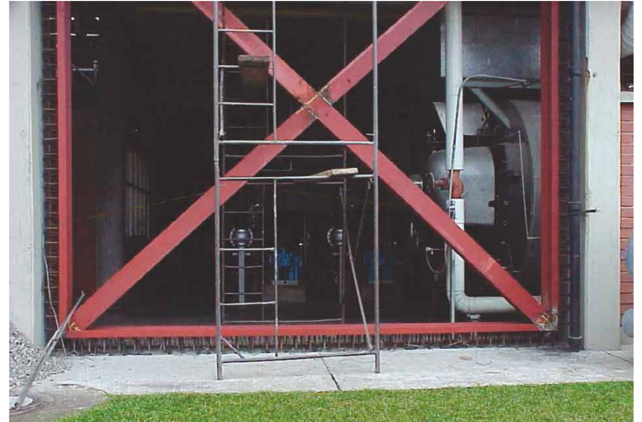
Arriostamiento metálico con conexión indirecta en edificio industrial
