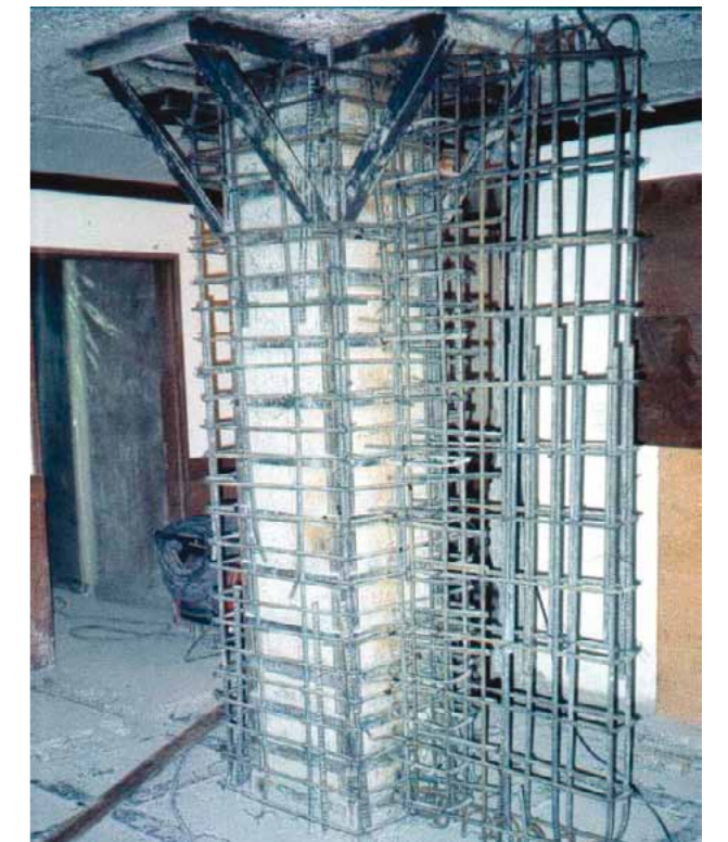
Encamisado y adición de muro lateral en concreto reforzado de columna en edificio comercial
