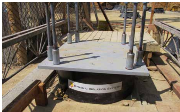
Aisladores en edificio (Colombia)
