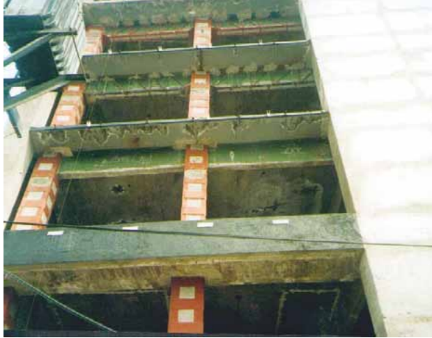
Angulos y platinas metálicas en columnas y vigas de edificio de oficinas
