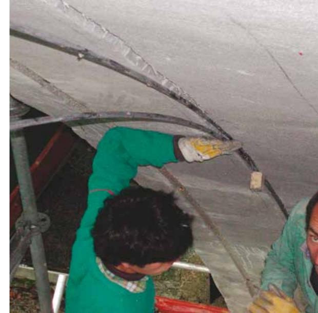
Varillas CFRP colocadas en ranuras en puente de concreto
