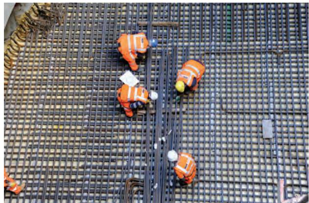
Acero de refuerzo en la losa de una estructura para contener líquidos. Se prefieren las barras de acero con diámetros pequeños y con separaciones pequeñas para minimizar el riesgo de que aparezcan fisuras con anchos grandes mayores a lo permitido.
