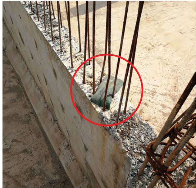
Cinta de PVC mal centrada en el muro de un tanque.
